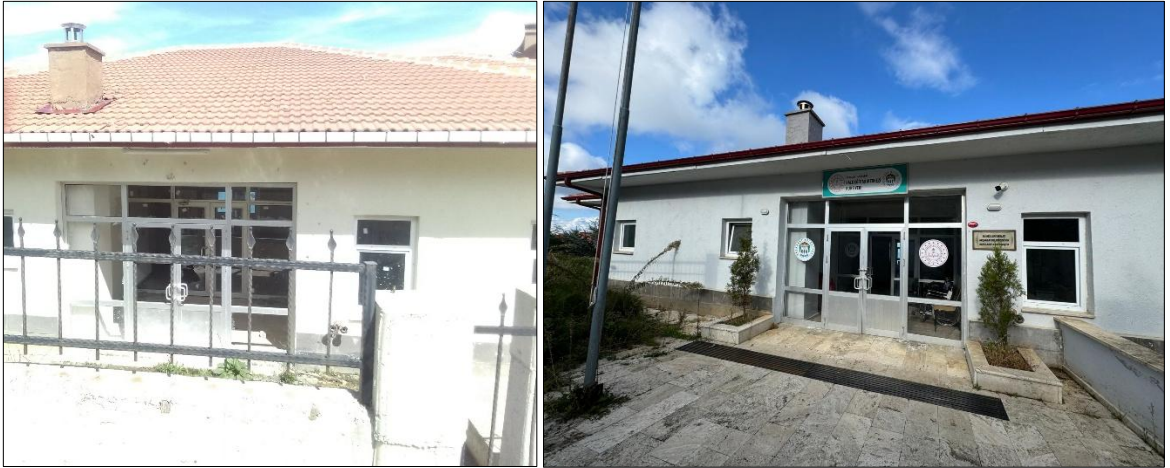
Şekil 19. Yıldızlı TOKİ yoksul konut yerleşiminde 2018 yılında (solda) sağlık tesisi olarak inşa edilen yapının 2024 yılında (sağda) halk eğitim merkezi olarak kullanılması
