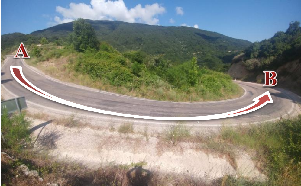
Şekil 2: Yol Üzerinde Dever Örneği (Balıkesir, Erdek-Turanlar Yolu)
