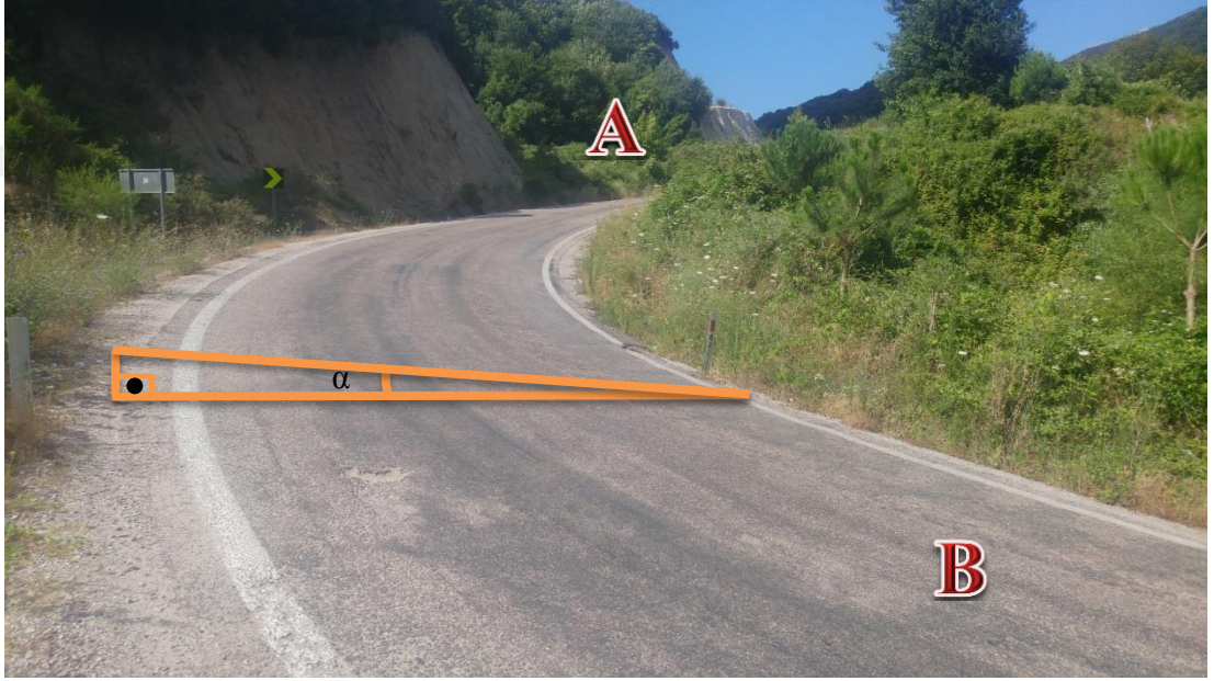
Şekil 3: Yol Üzerinde Dever Örneği 2 (Balıkesir, Erdek-Turanlar Yolu)
