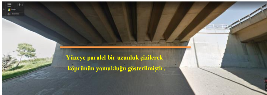
Şekil 105: Uygulamaya Göre Şekil 104’deki Hatalı Dever Noktasının Yol Üzerindeki Görünümü 3
