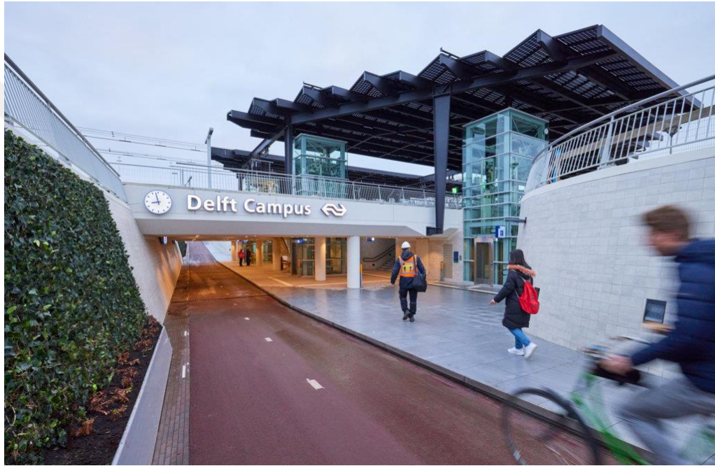
Görsel 5.4. Delft Kampüs İstasyonu Modern Tasarımı, Delft, Hollanda (Strukton Rail, 2021)
