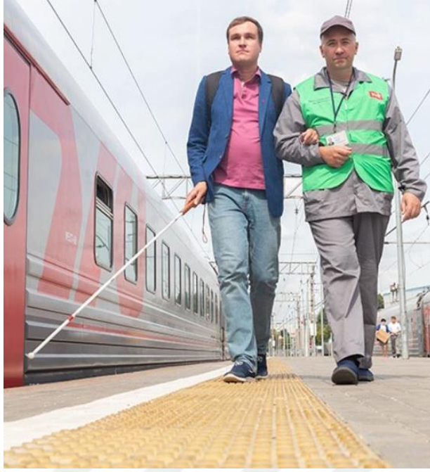
Görsel 3.31. Engellilere Yönelik Zemin Kaplamaları, Rusya (Global Railway, 2021)
