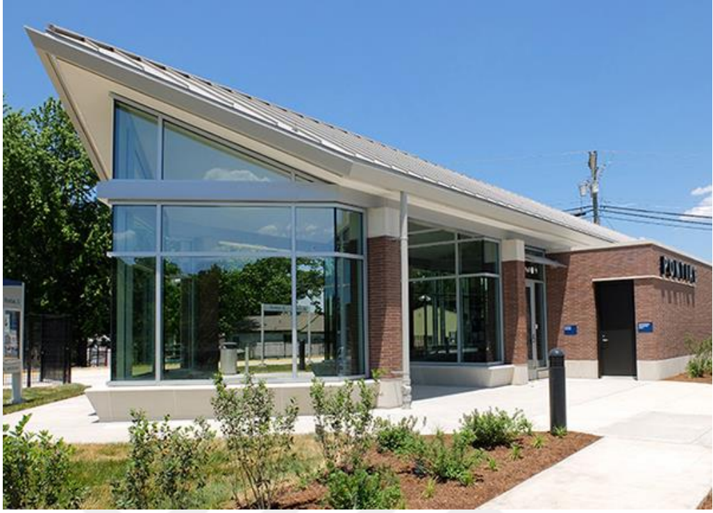
Görsel 5.14. Illinois Bölgesel Demiryolu İstasyonu, Chicago, Amerika (Legat Architects, 2022)
