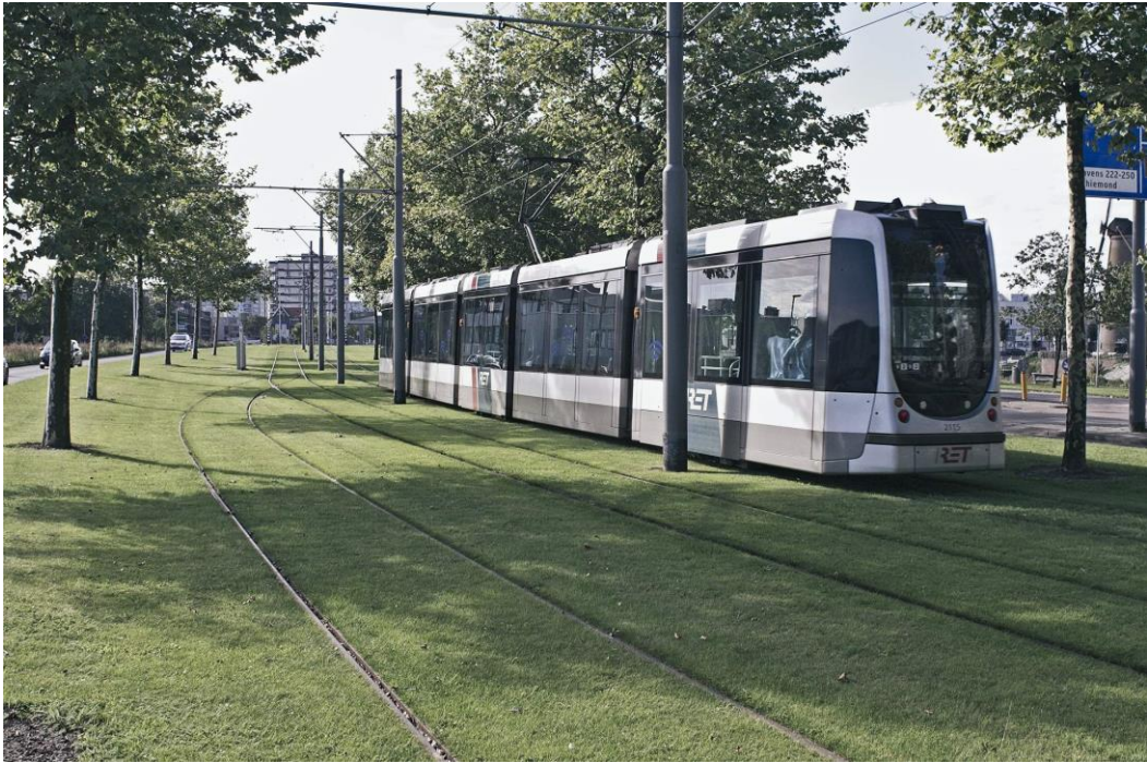
Görsel 4.14. Rotterdam tramvay hattı bitkilendirme çalışması ( http-11 )
