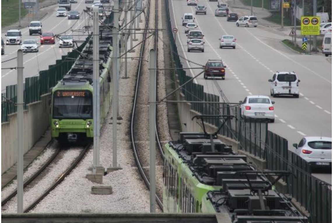
Görsel 4.17. Bursa hafif raylı sistem hattında bariyer kullanımı (http-13)
