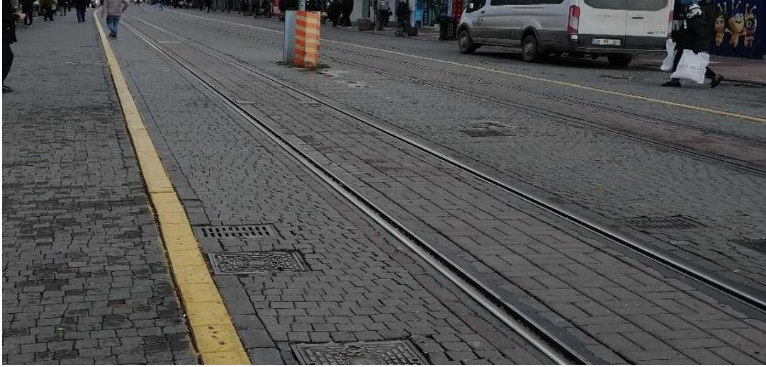
G rsel 4.4. Eskiřehir tramvay hattı sarı řerit kullanımı
