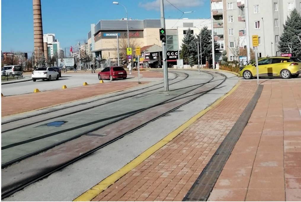
Görsel 4.19. Eskişehir tramvay hattı sinyalizasyonu
