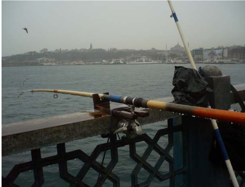
Şekil 4.20 : Köprü korkuluklarına bağlanan olta tutacağı (T. Şahin Arşivi).
