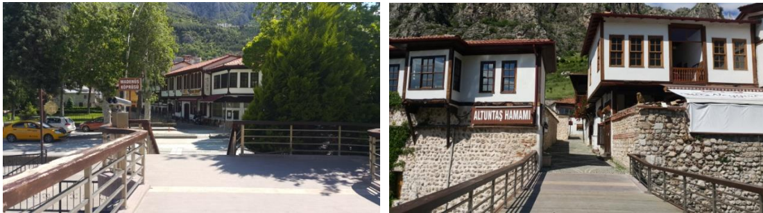
Şekil 4.23 Magdenüs Köprüsü Giriş ve Çıkışı
