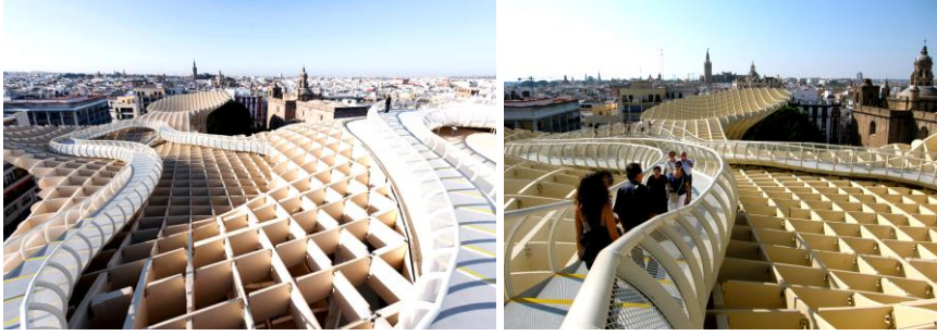
Resim 4.8. J. Mayer H. Architects, Metropol Parasol üst örtüsü [www.archdaily.com]
