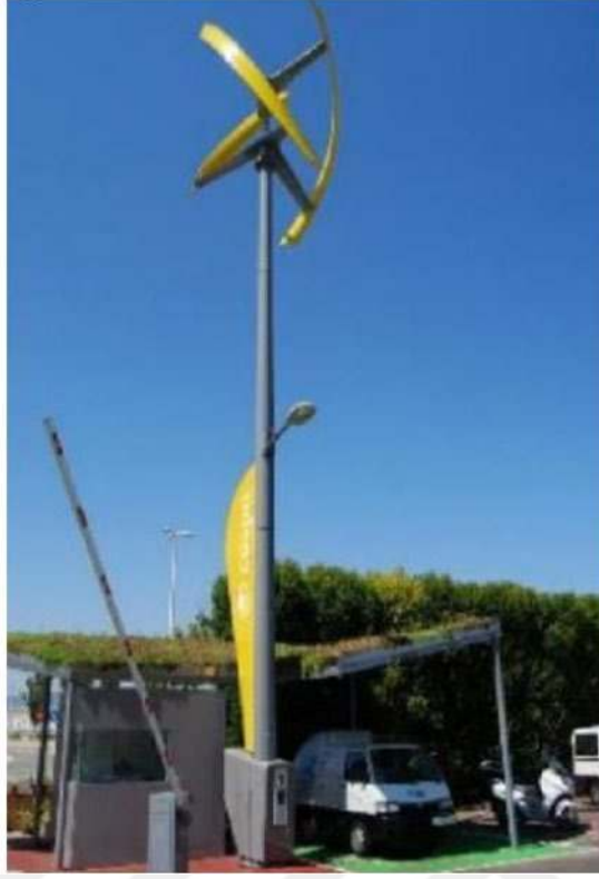
Şekil 5.11. Rüzgâr enerji santralini kullanan şarj istasyonu.
