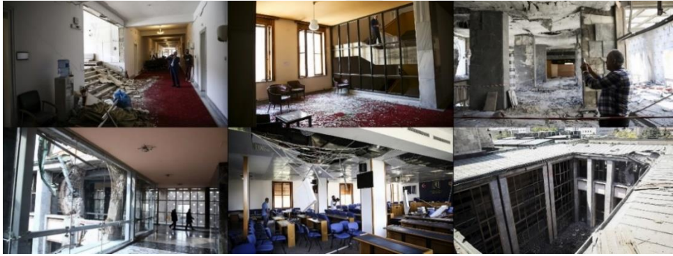
Resim 3.2. 15 Temmuz TBMM saldırısı yapı hasarı (URL-1)
