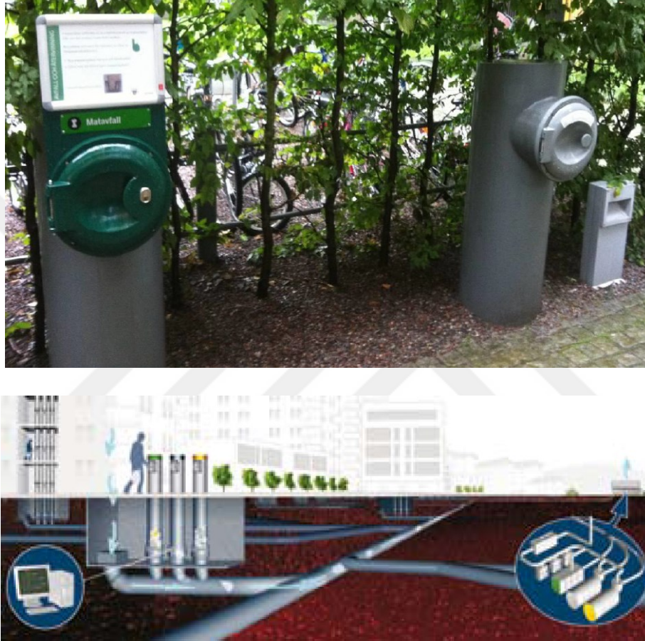
Şekil 4.21: . Kilitli metal çöp kutuları ve vakumlu ayrıştırılmış katı atık toplama sistemi (Fränne,2007).
