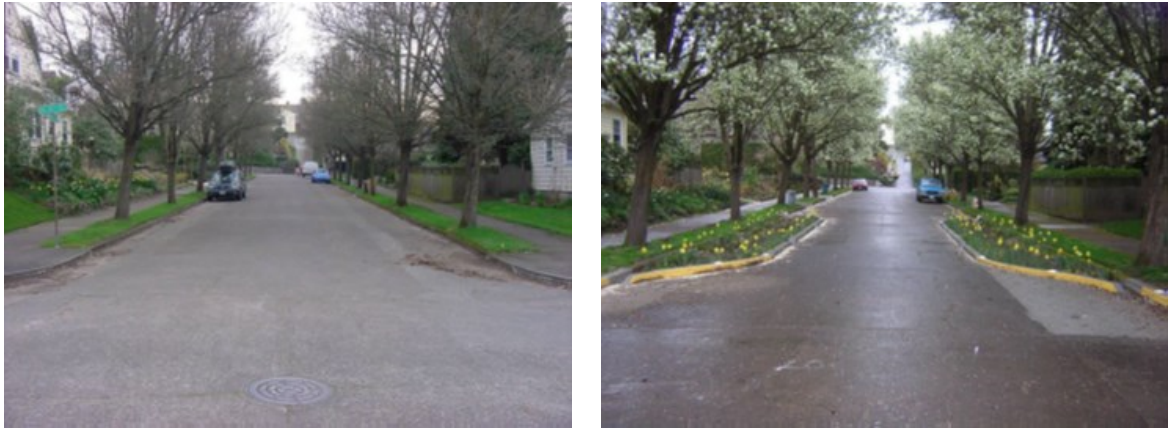
Şekil 4.6: NE Siskiyou & 35th kaldırım uzantıları (Curb Extensions) Portland Oregon ABD örneği (2003), (Wethington,2015).
