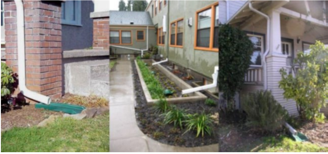
Şekil 4.1: Portland bağlantısız iniş borusu (Disconnected Downspout) uygulamaları (Wethington,2015),(URL-27).
