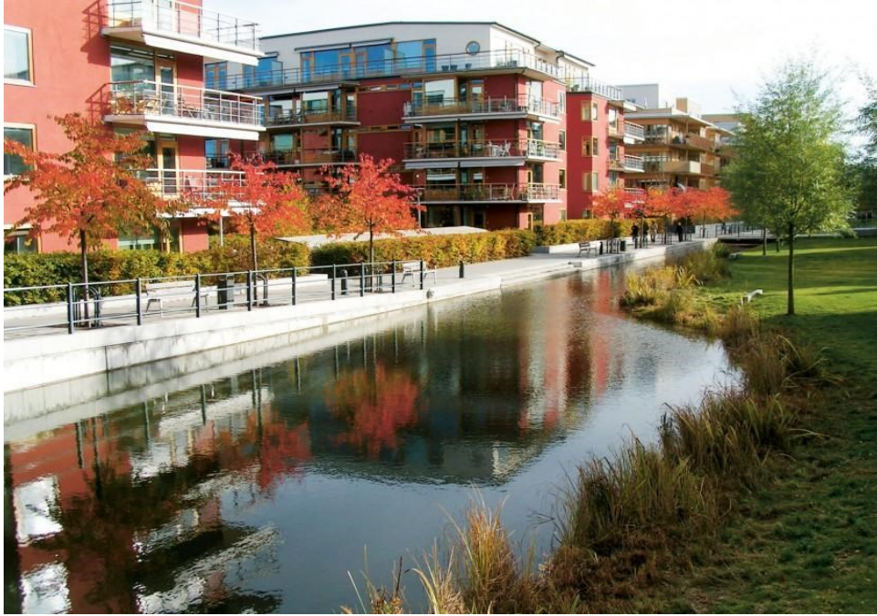
Şekil 4.17: Yağmur suyu yönetiminde yer alan kanal örneği (URL-30).
