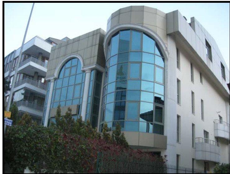
Resim 3.29. Giydirme cephe ile yunan sütunlarını birlikte kullanan bir iş yeri binası Şh. Ömer Haluk Siphaioğlu Sok. (2949 Ada/62 Parsel)
