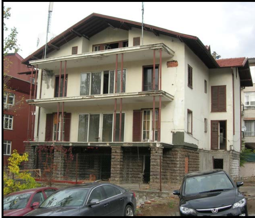
Resim 3.12. Tip 2, Halıcı Sokak (4430 Ada, 13 Parsel)
