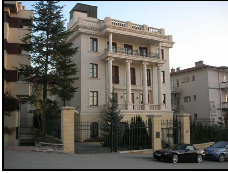
Resim 3.28. 2000’li yıllarda yapılan yeni şirket binalarından biri Şh. Ömer Haluk Sipahioğlu Sok. (2949 Ada/26 Parsel)
