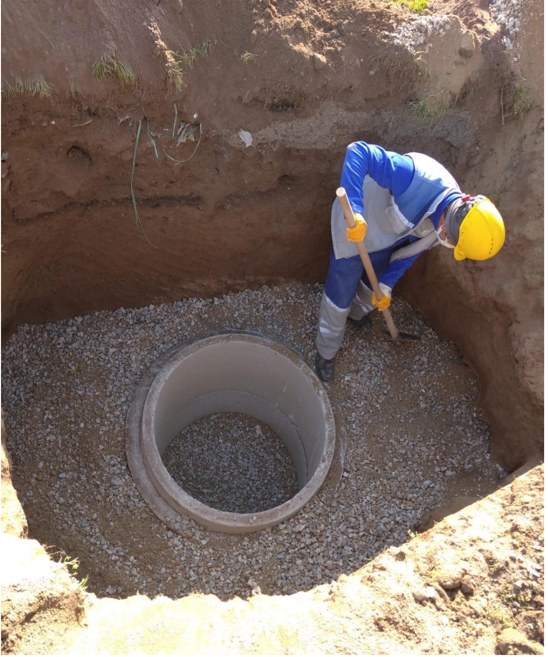
Şekil 3.22. Yeraltına sızdırmalı baca yapımı KASKİ uygulaması
