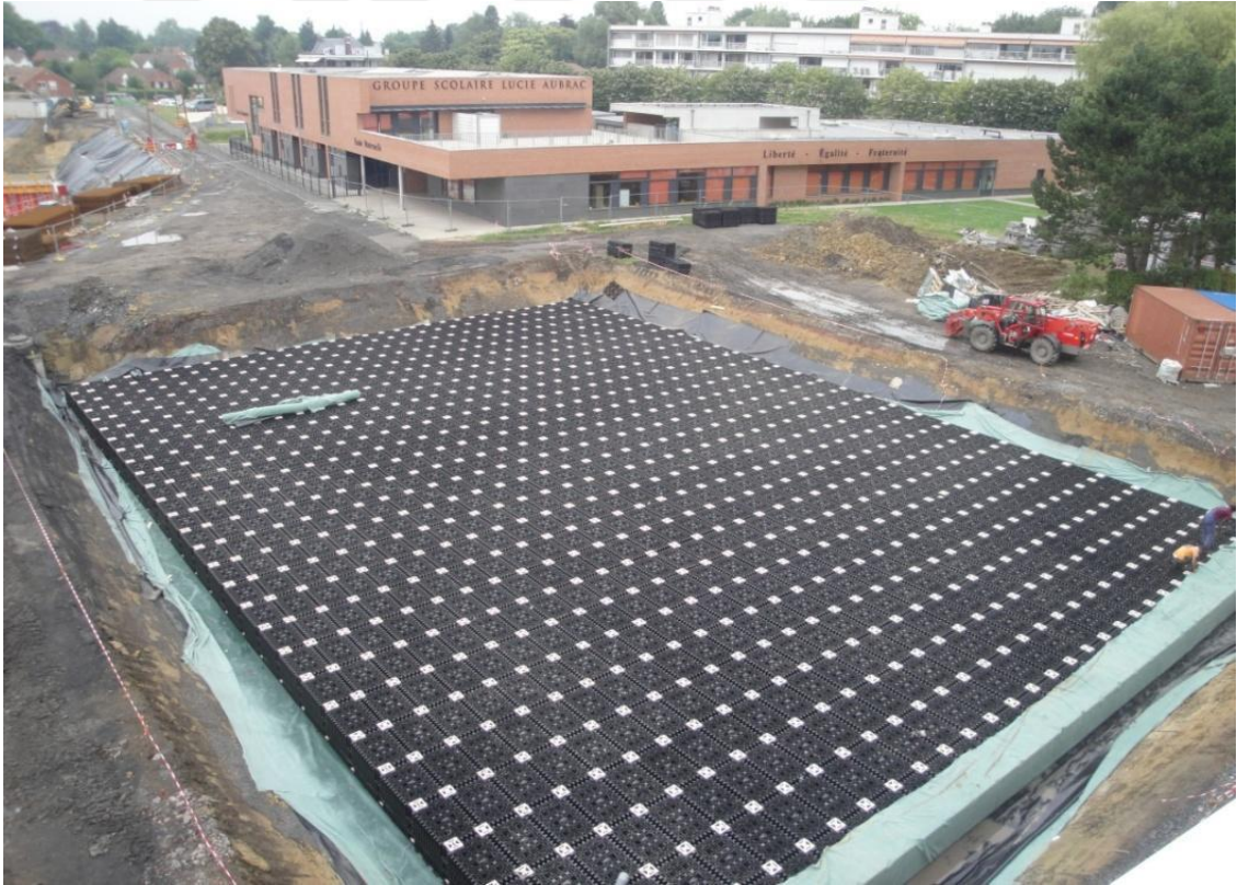
Şekil 2.12. Yer altı yağmur suyu depolama örneği (Kaski Birim İçi Sunum)
