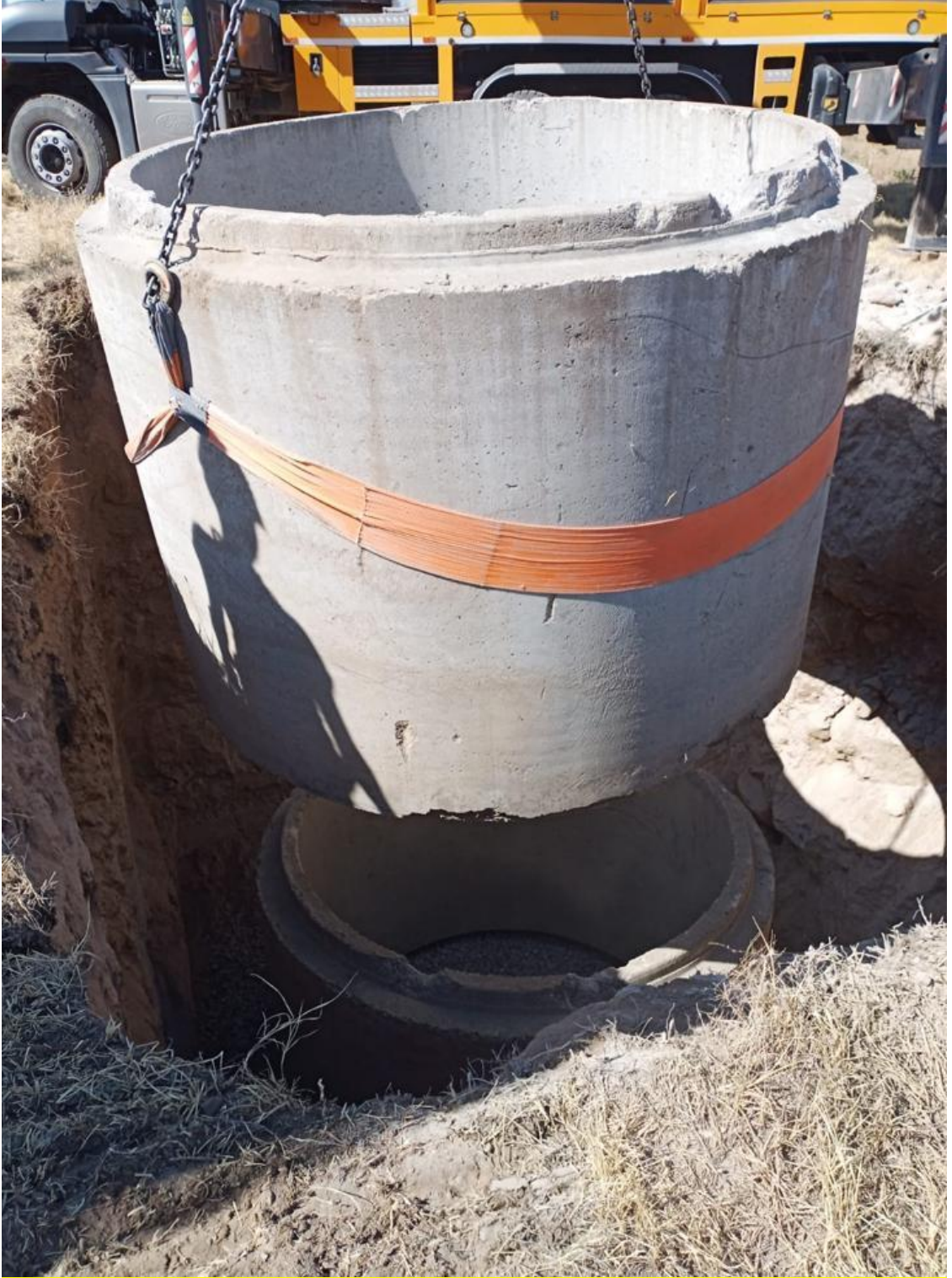
Şekil 2.17. Yağmur hasadında uygulanan Ø2600 mm beton büzün yerleştirilmesi aşaması
