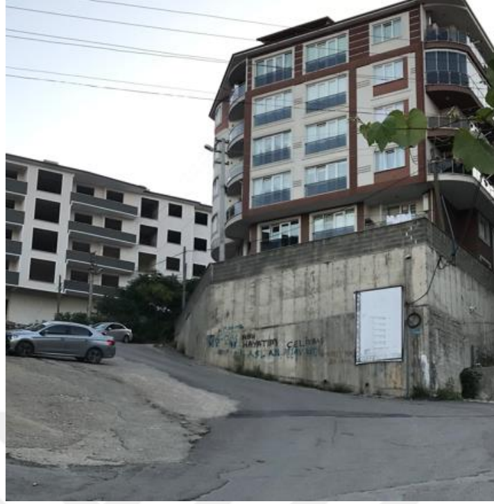
Şekil 4.46: Bartın Cumhuriyet mahallesi istinat duvarları
