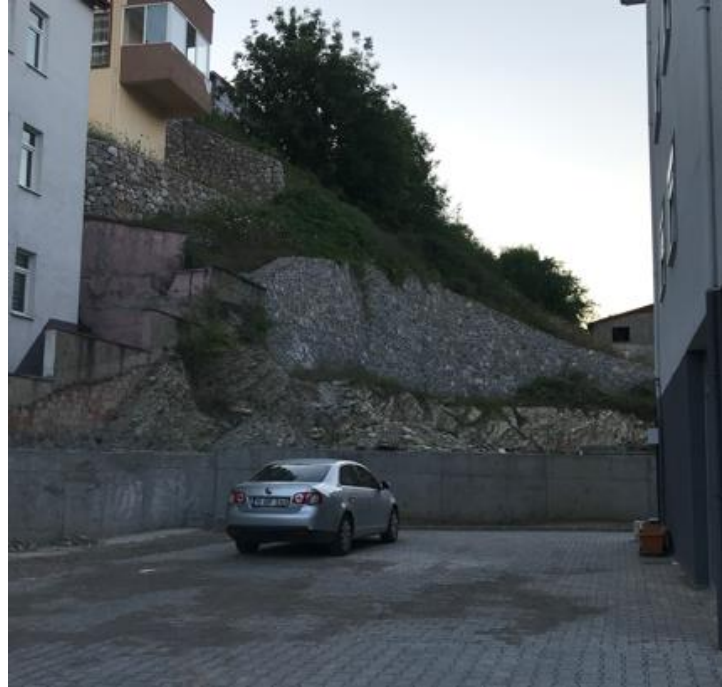
Şekil 4.45: Bartın Aladağ mahallesi istinat duvarları
