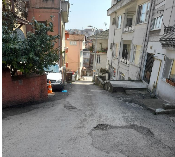
Şekil 4.25: Bartın Kırtepe mahallesinde düzensiz yapılaşma
