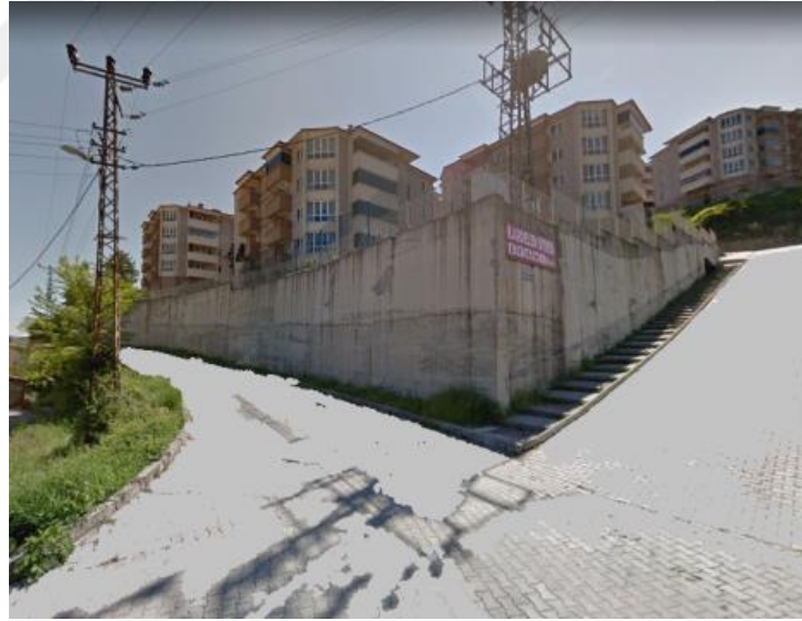
Şekil 4.47: Bartın Gölbucağı mahallesi istinat duvarları
