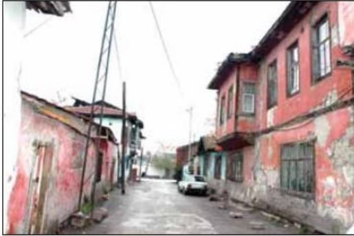
Dutlu Sokak'ın Sokak Sağlıklaştırma Projesi öncesi durumu
