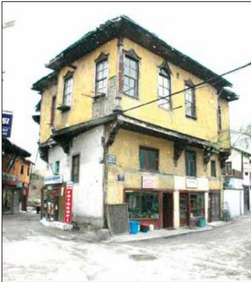
Sarıkadı Sokak'ın Sokak Sağlıklaştırma Projesi öncesi durumu
