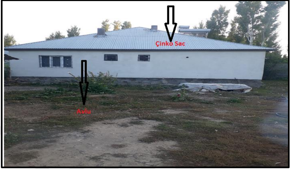
Fotoğraf 21: Alpaslan Mahallesi 238. Sokakta Bulunan Müstakil Bir Konutun Çatı Sistemi
