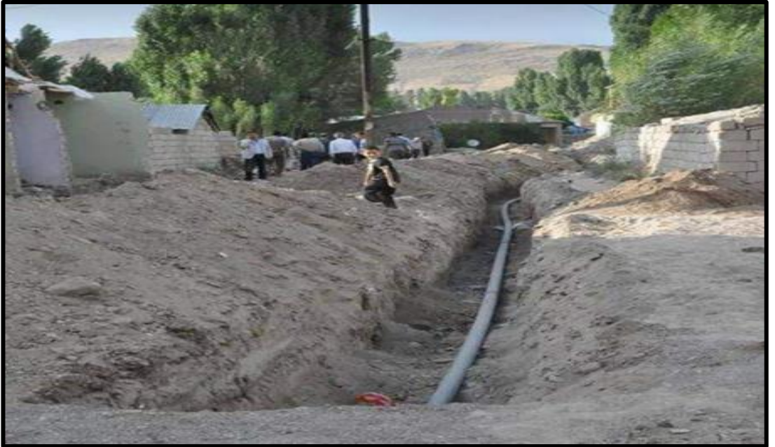
Fotoğraf 37: Bağdıran Mahallesi'nde Sokak Altyapı Çalışmalarından Bir Görünüm
