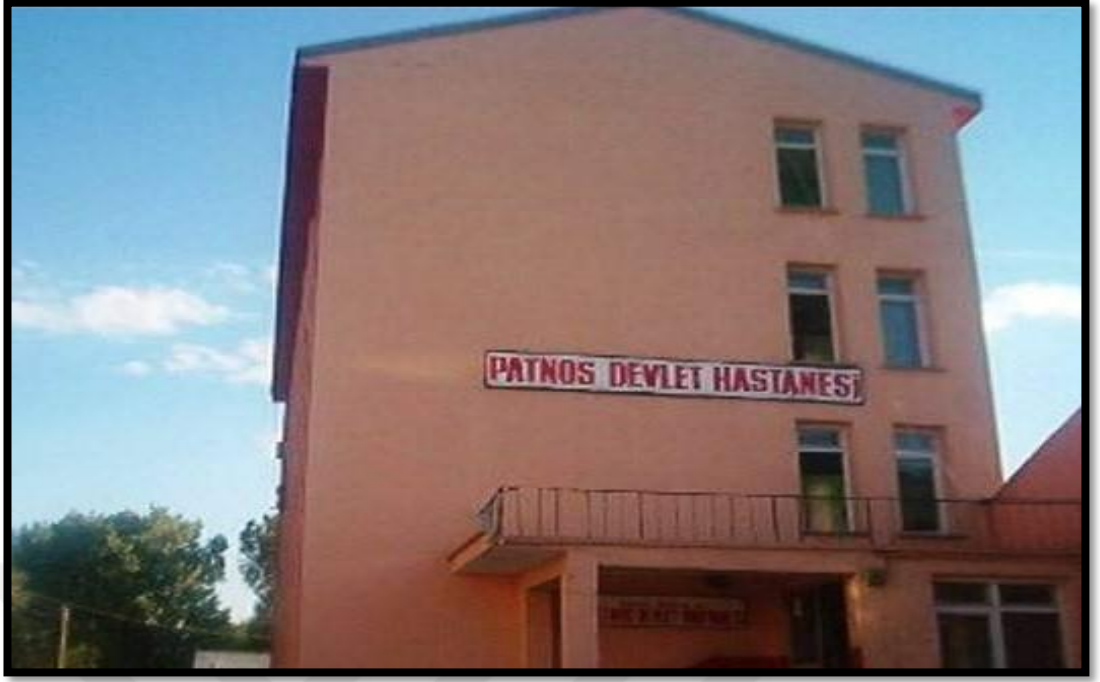
Fotoğraf 47: Patnos Devlet Hastanesi'nin Eski Hizmet Binası
