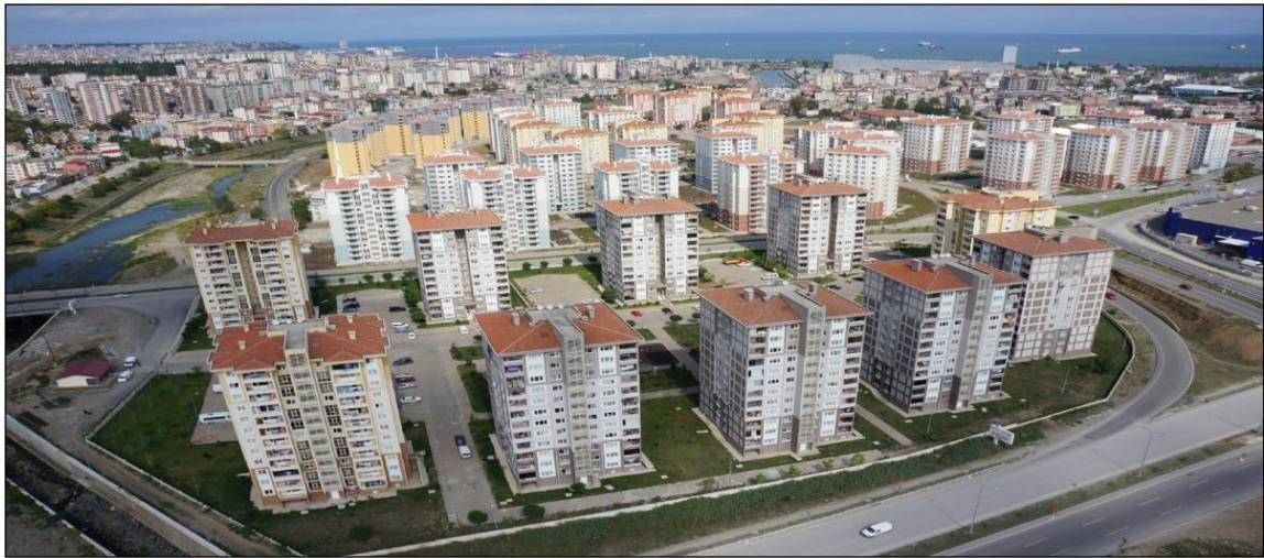
Şekil 8: Kuzey Yıldız Kentsel Dönüşüm Projesi Konutları ve Çevresi
