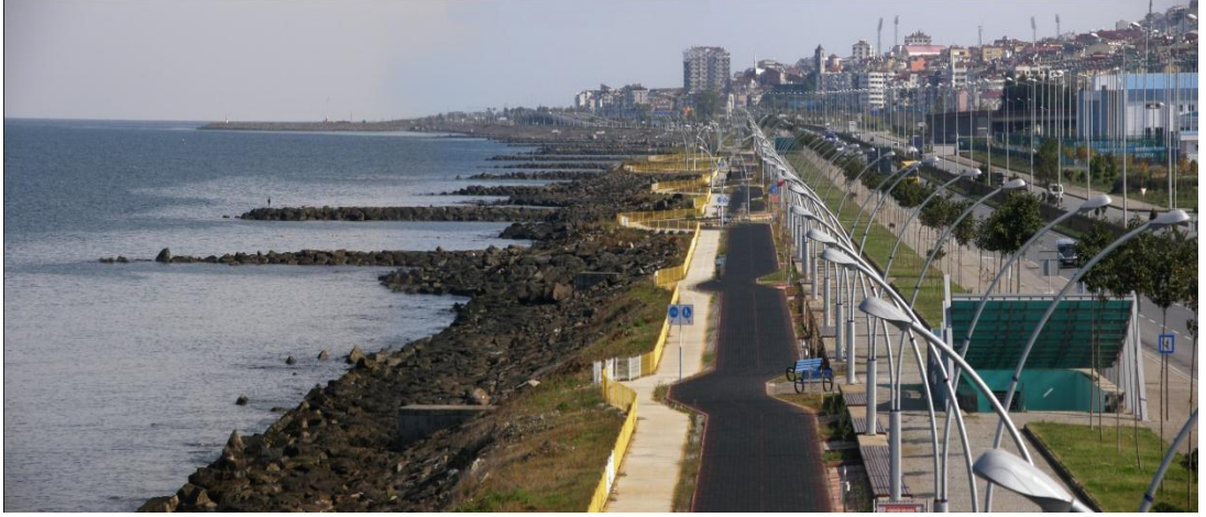
Şekil 12. Kiyı bandı batı cephesinden görünümü
