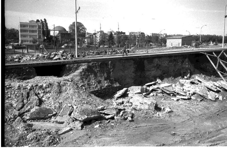
Görsel 2.1.8: Yol yapımı sırasında ortaya çıkan kalıntılar, Sarayhanı
