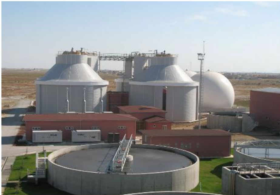
Şekil 3.14. Çamur yoğunlaştırma havuzları.
