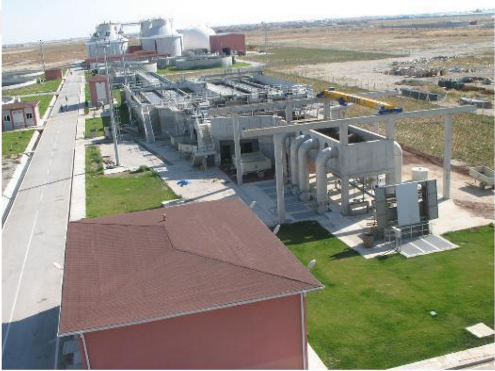
Şekil 3.5. Ön arıtma ünitesi fotoğrafı.
