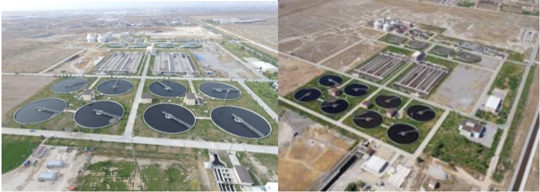
Şekil 3.2. Konya Kentsel Atıksu Arıtma Tesisi fotoğrafları.
