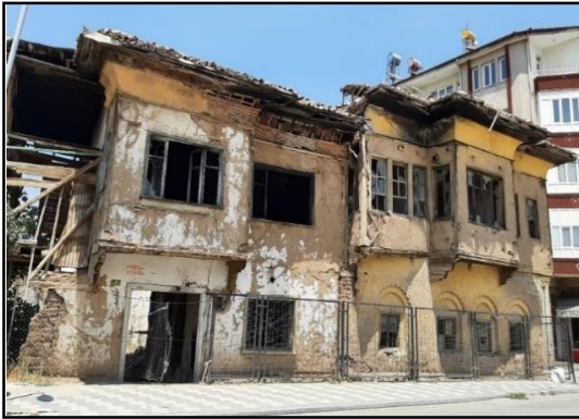
Şekil 4.16: Sefer Almasulu Evi Sokak Cephesi ve Avlu Girişi.
