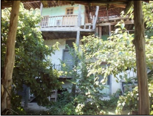
Şekil 4.54: 21 Nolu Ev Avlu Cephesi
