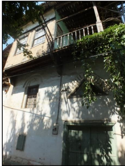
Şekil 4.56: 21 Nolu Ev Sokak Cephesi
