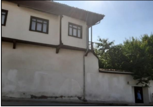
Şekil 4.60: Yeşilyurt 116 Nolu Ev Sokak Cephesinden Avlu Girişi
