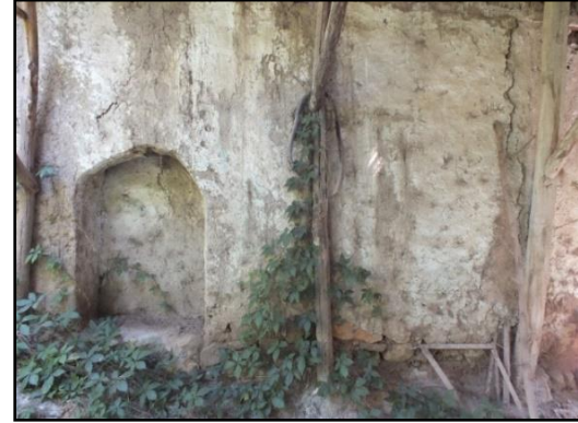
Şekil 4.55: 21 Nolu Ev Avluda Bulunan Ocak Detayı
