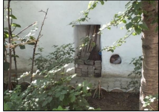
Şekil 4.61: Yeşilyurt 116 Nolu Ev Avludan Detaylar
