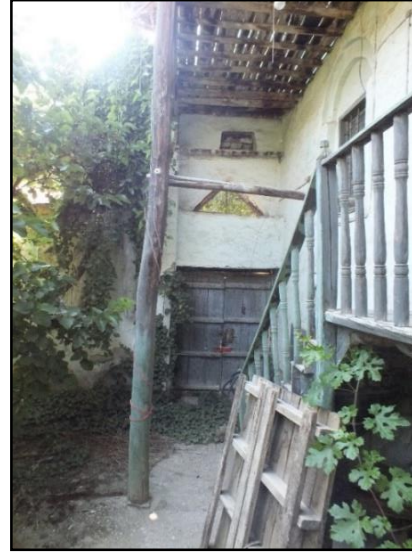
Şekil 4.57: 21 Nolu Ev Avlu Girişi
