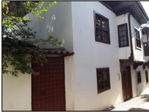
Şekil 4.99: Gültek Sokak 7 Nolu Ev
