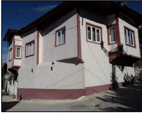
Şekil 4.49: Yeşilyurt 2 Nolu Ev Sokak Cephesi
