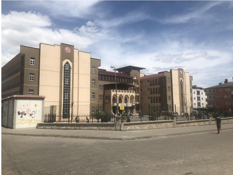
EK- 11. 2. Etap Kentsel Dönüşüm Alanında Yapılan Okul Binası
