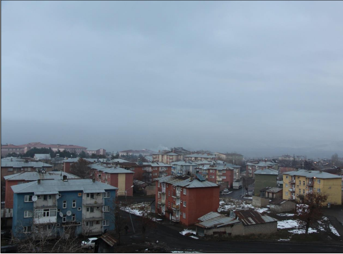
Şekil 4.4. İnönü Mahallesi yıkım gerçekleşmeden önceki hali ( https://www.capakcurgazetesi.com.tr ) (Erişim Tarihi: 04.02.2019)
