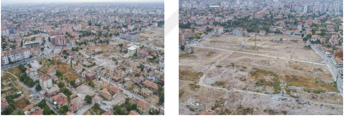
Şekil 4.11. Çalışma alanının kentsel dönüşüm öncesi hali ve yıkım ile tahliye sonrası hali (Bayrak, 2019)
