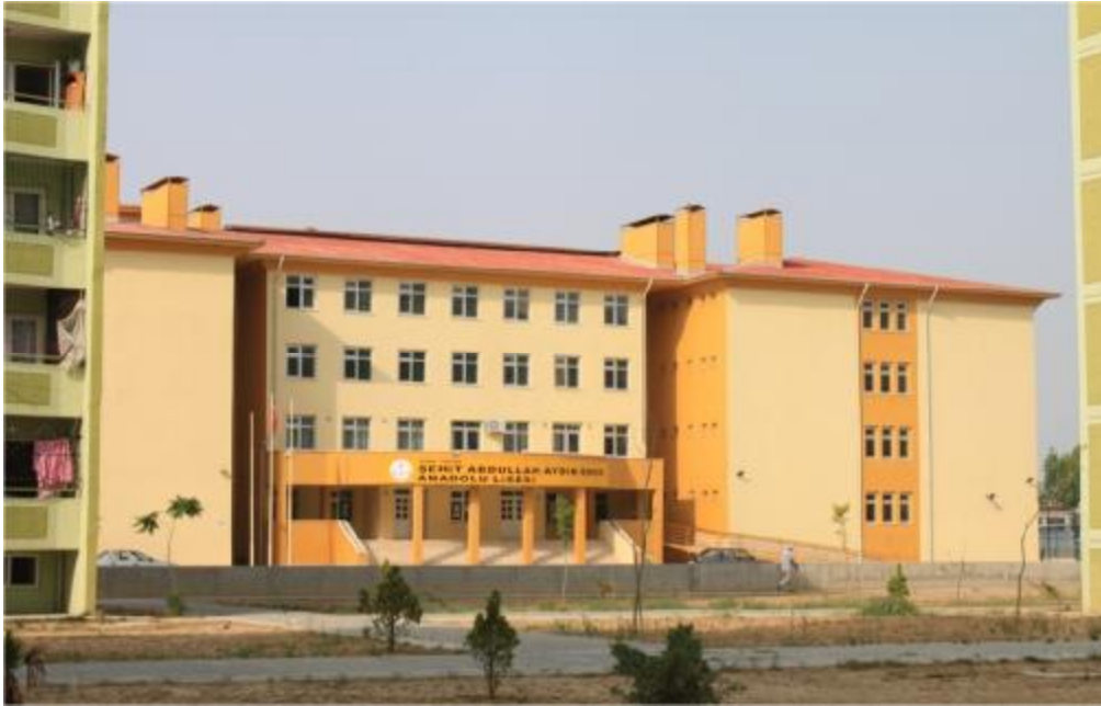
Şekil 4.21. Okul binası ön görünüş
