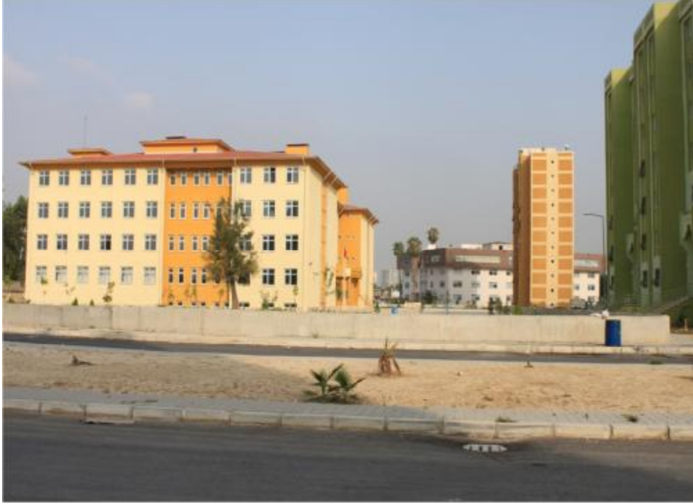
řekil 4.22. Okul binası yan görünüş
