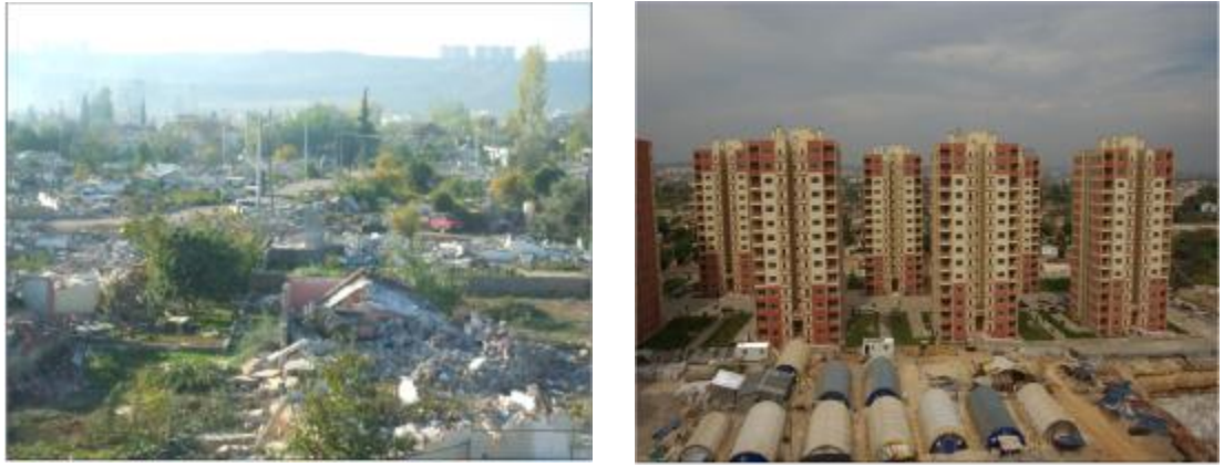
Şekil 4.6. Proje öncesi hali ve proje uygulaması esnasında hali
