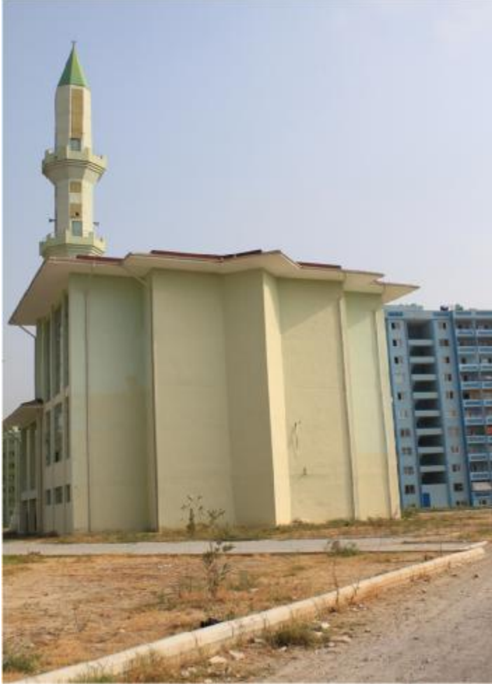
Şekil 4.24. Cami yan görünüş
