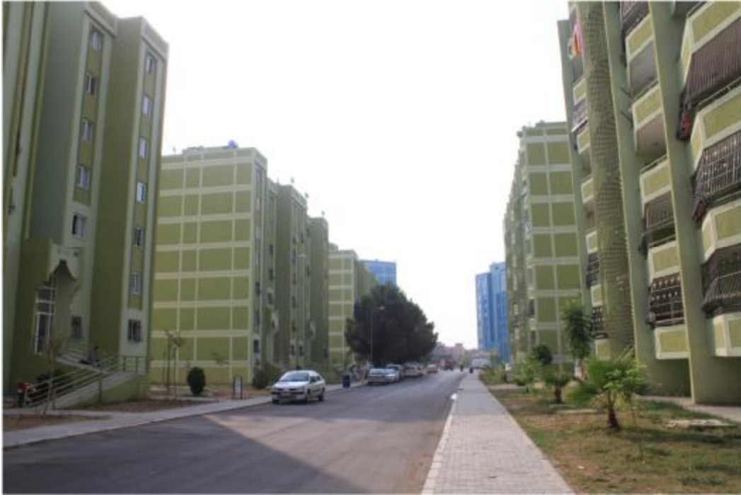
Şekil 4.16 FG Tipi konutlar genel görünüş
