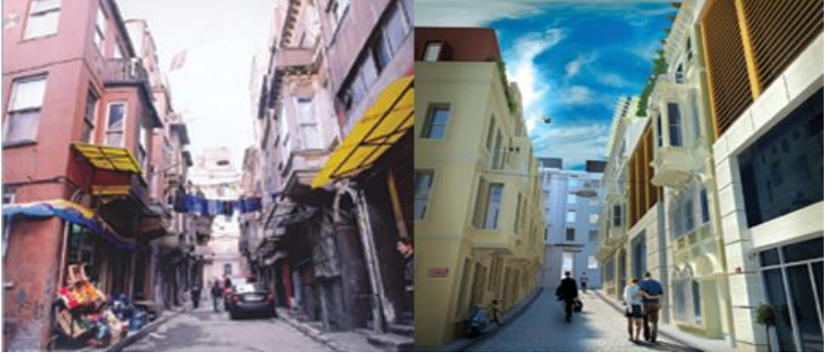
Şekil 16. Tarlabası Kentsel Dönüşüm Projesi Aynı Sokak Öncesi ve Sonrası (URL-12)
