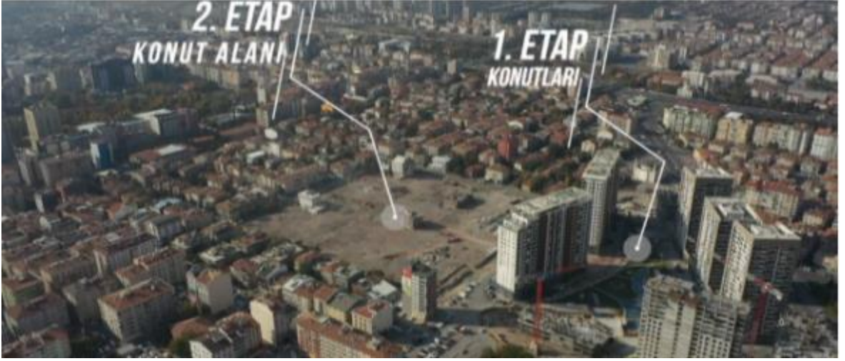
Şekil 19. Sahabiye Kentsel Dönüşüm Projesi 1. ve 2. Etap Proje Sahası (URL-16)
