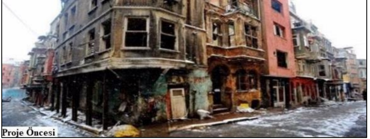
Şekil 14. Tarlabası Kentsel Dönüşüm Projesi Öncesi (URL-10)
