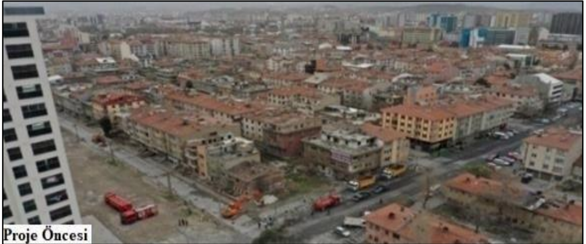
Şekil 17. Sahabiye Kentsel Dönüşüm Projesi Öncesi (URL-14)
