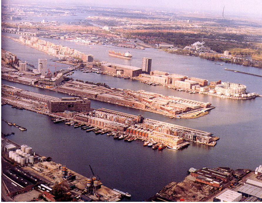
Şekil 3.5 Eski liman bölgesinin budünkü durumu, Amsterdam
