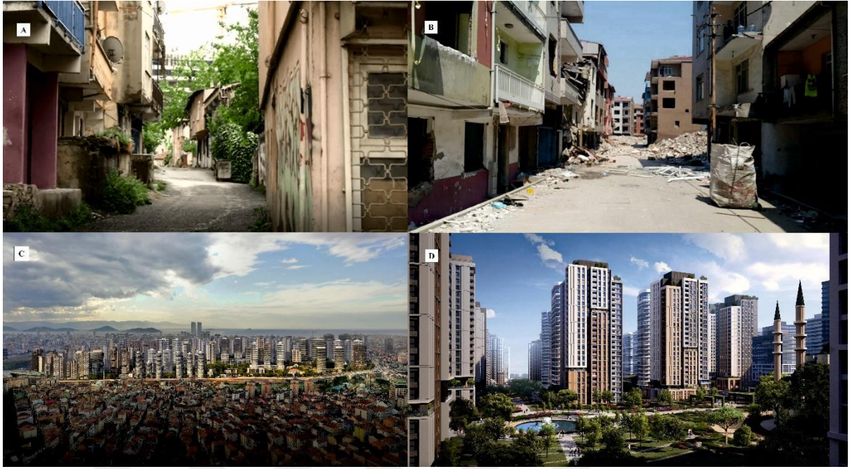
Fotoğraf 1. 4 Fikirtepe Kentsel Dönüşüm Öncesi ve Sonrası Alanda Gelişen Konut Yapısı
