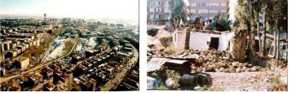
Şekil 3.27 Portakal Çiçeği alanı ve yıkım çalışmaları ( Göksu, 2004)
