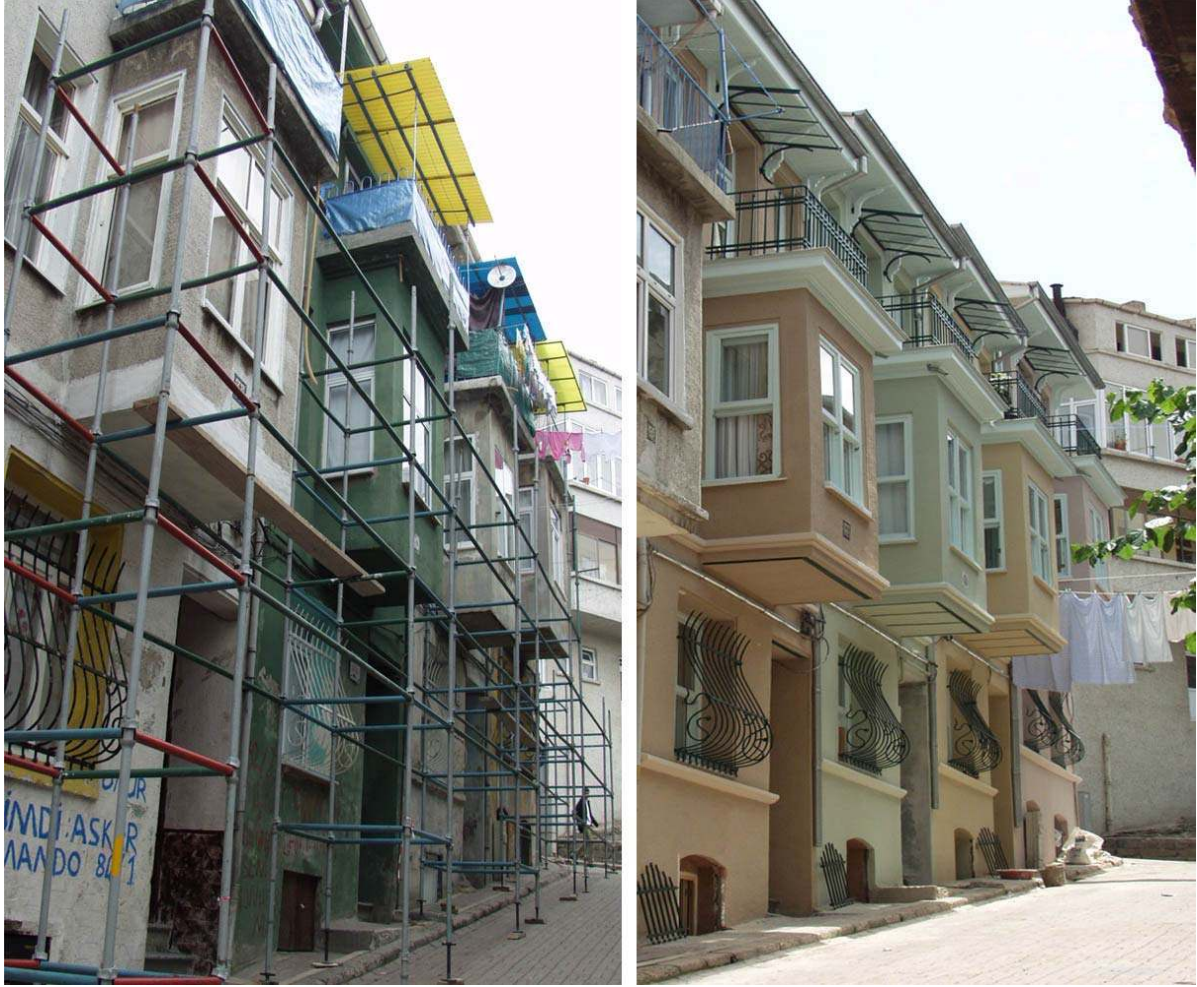
Şekil 3.38 Sütlaç Sokak, restorasyon öncesi ve sonrası (www.fenerbalat.org)
