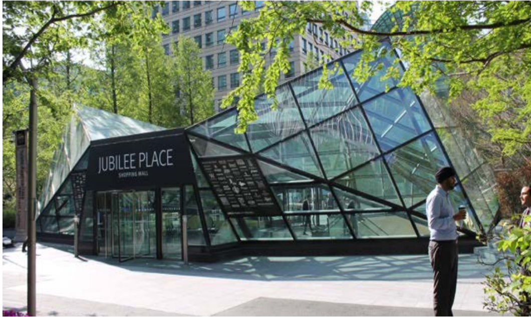
Şekil 2.14: Yer altı alışveriş merkezi girişi.
