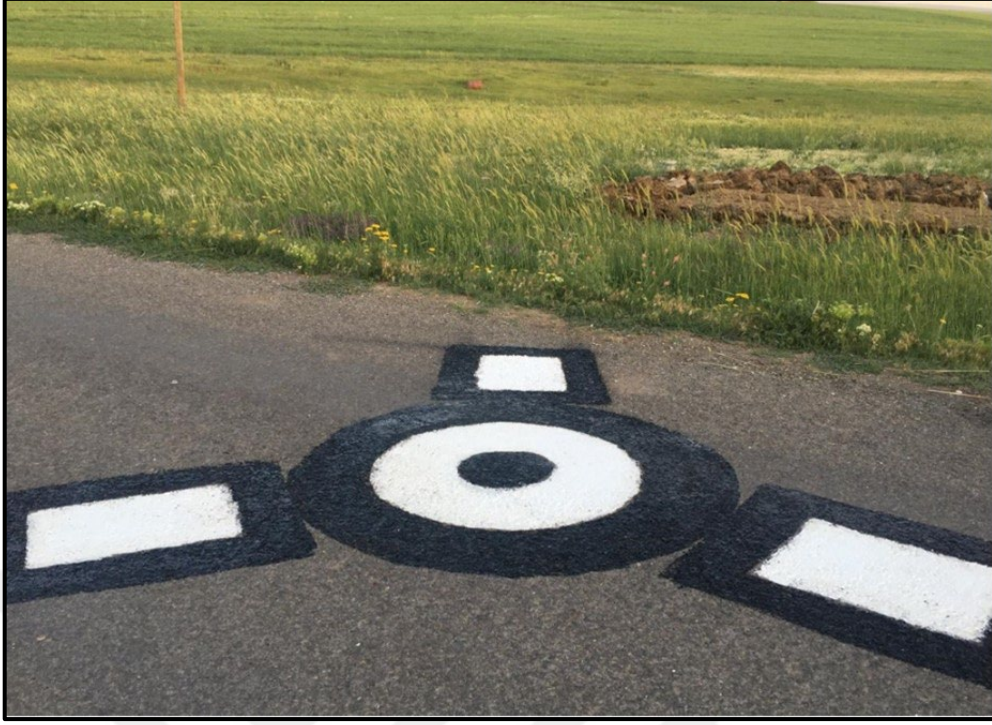
Şekil 1. 3. Yer Kontrol noktası tesisi (URL-1, 2024)
