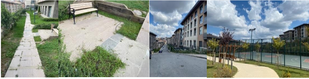
Resim 5.15. Döşeme elemanları (Yazar tarafından çekilmiştir)
