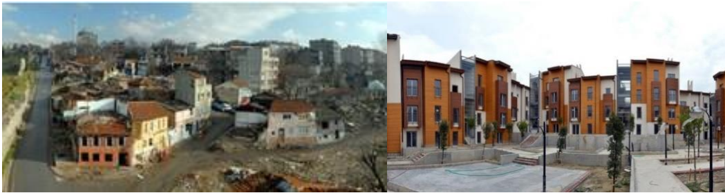
Resim 2.5. Sulukule kentsel dönüşüm projesi öncesi ve sonrası (Ur1-5)
