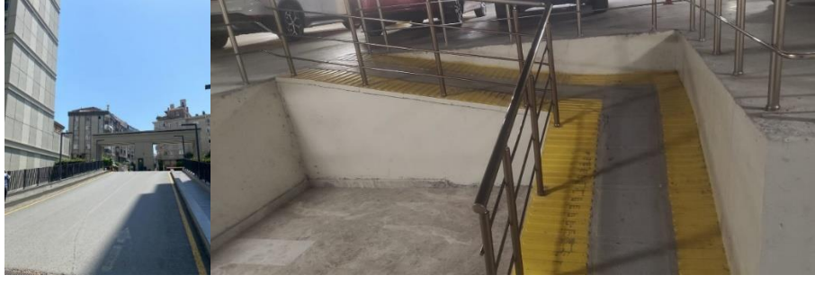
Resim 5.29. Rampalar (Yazar tarafından çekilmiştir)
