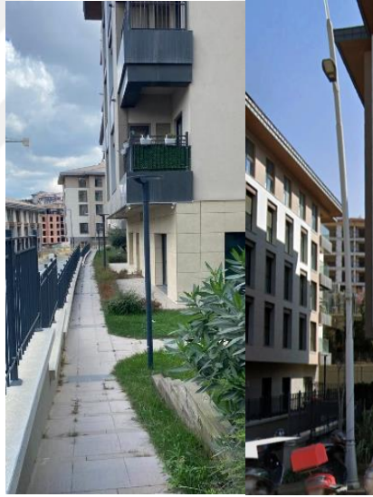
Resim 5.10. Aydınlatma elemanları (Yazar tarafından çekilmiştir)
