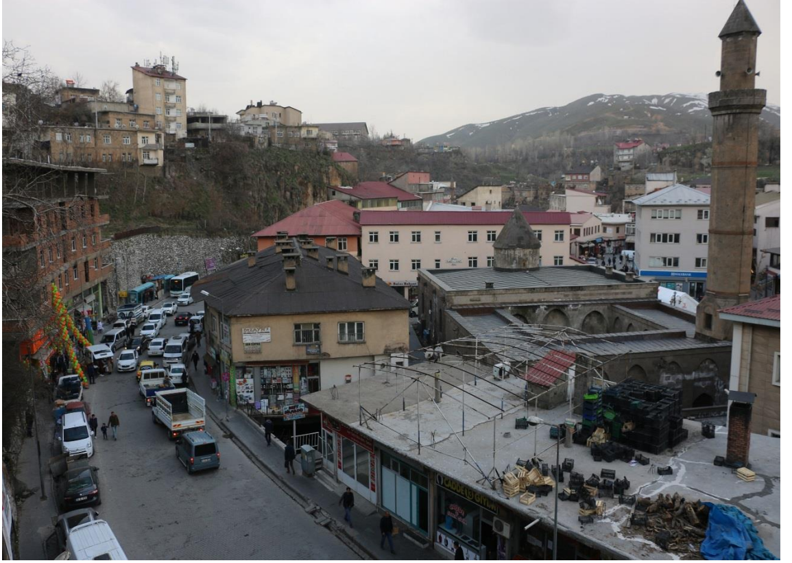
Fotoğraf 3.1. Bitlis Merkez Çarşı (Kentsel Dönüşümden Önceki Hali)
