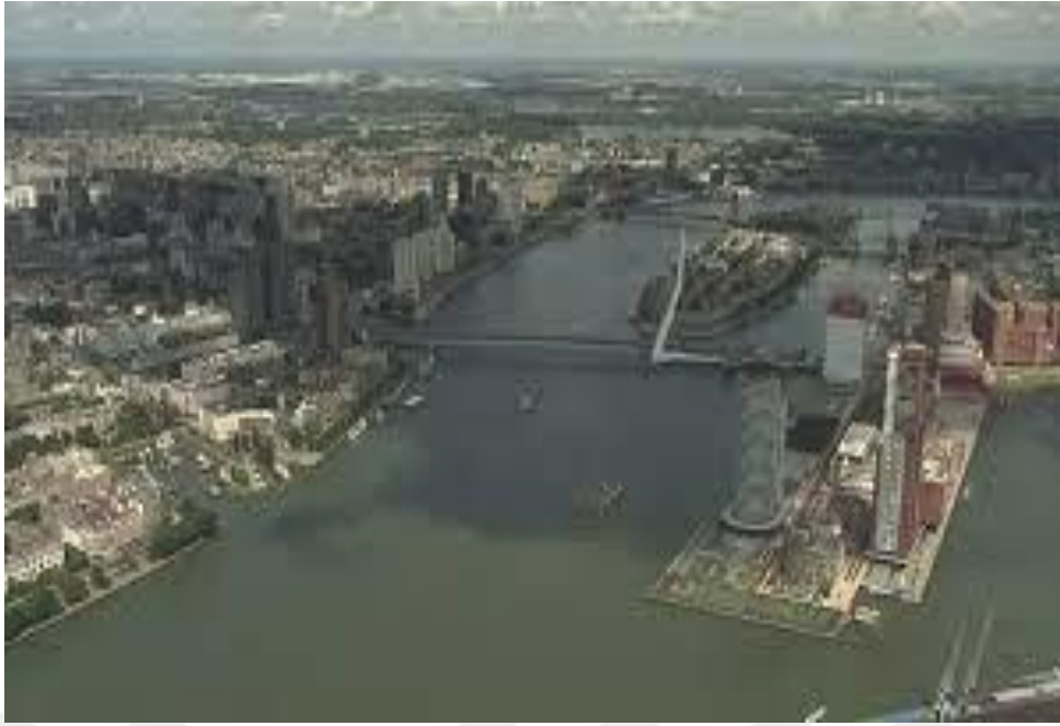
Şekil 6. Erasmus Köprüsü ve Kop Van Zuid. 145
