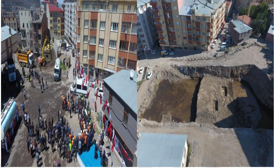
Şekil 22.Yukarı Mumcu mahallesi kentsel dönüşüm projesi yapım aşaması. 242
