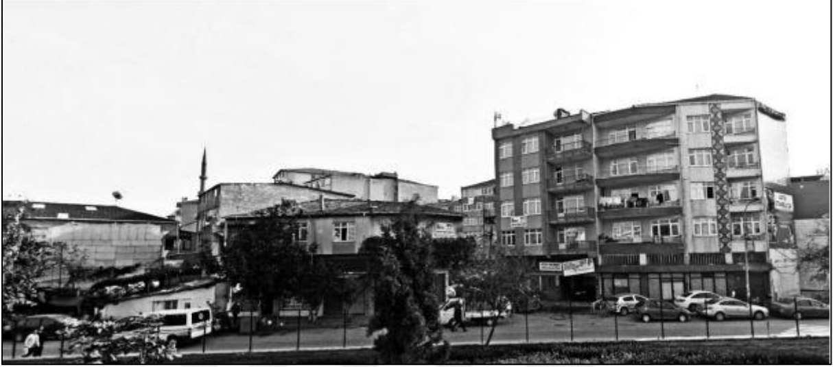
Şekil 5.9. Fikirtepe Kentsel Dönüşüm Alanından Görüntü.
