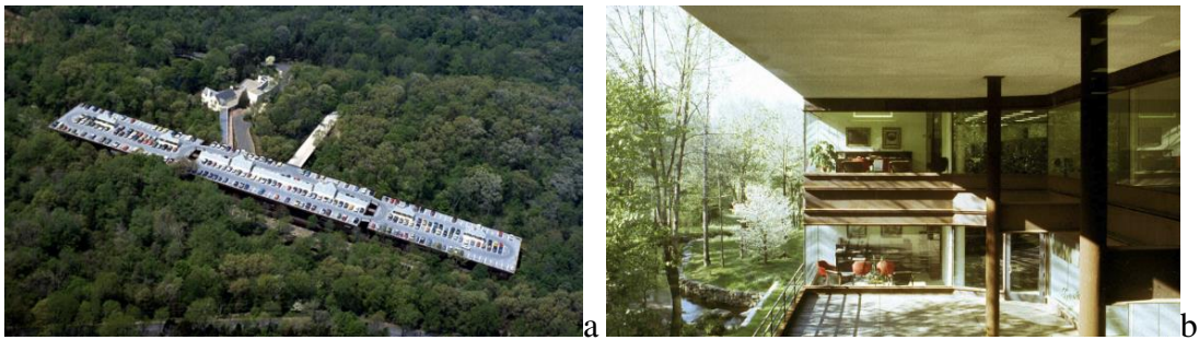
Şekil 2.21 Richardson-Vicks Inc. Headquarters binası çevre ile ilişkisi (Hidden Architecture, n.d.) (Amerika, 1975)
