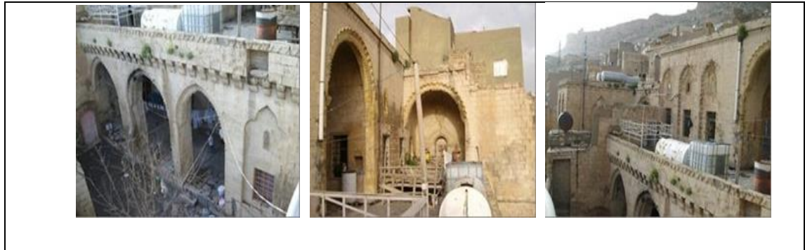
Şekil 4.108. Yapı’ya Ait Avludan Fotoğraf (Karagülle,2008)
