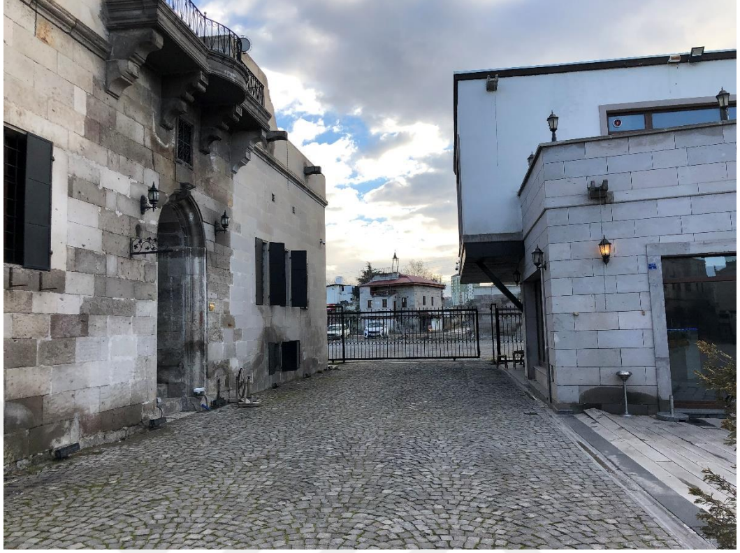
Şekil 5. 2 Kentsel Sit Alanı'ndaki tarihî yapılar ve sit alanını atıl durumda olan mahalleden ayıran demir kapı, 2023
