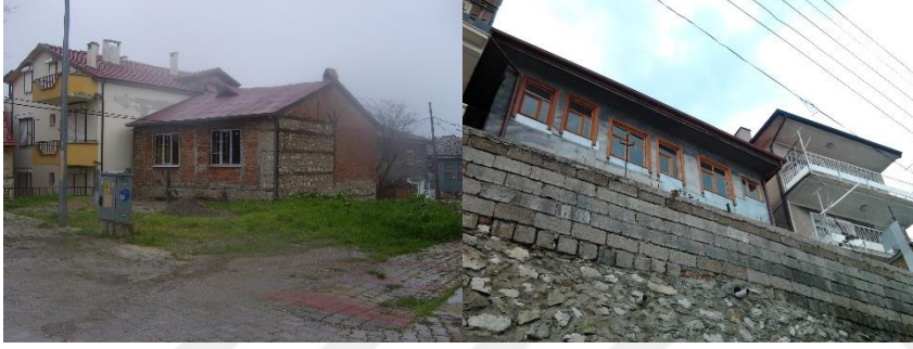
Resim 4.95. Özgün dolgu malzemesi sökülüp, yerine kiremit tuğla doldurulan yapı ve doğramaları değiştirilen ve sac kaplanan geleneksel yapılar
