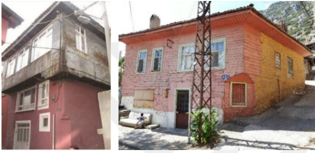
Resim 4.73. Geleneksel evlerin köşelerindeki pahlara örnekler
