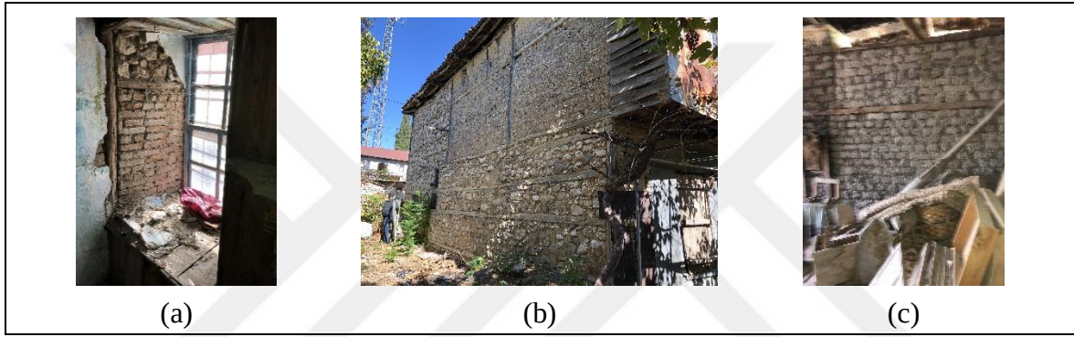
Resim 4.66. Geleneksel Eğirdir evlerinde duvar dolgusu (a) tuğla dolgu, (b), (c) kerpiç dolgu
