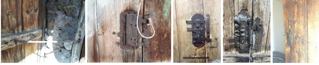
Resim 4.41. Geleneksel Eğirdir evlerindeki dış kapılarda yer alan kilit örnekleri
