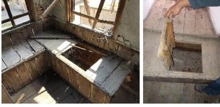
Resim 4.52. Sekilerde bulunan gizli dolap kapakları
