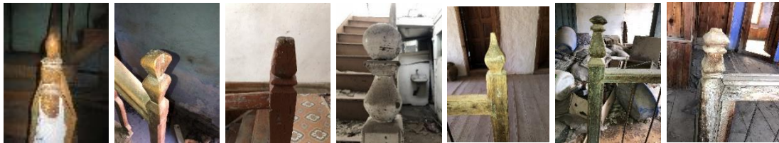
Resim 4.61. Geleneksel Eğirdir evlerinde merdiven topuzu (zavrak) örnekleri
