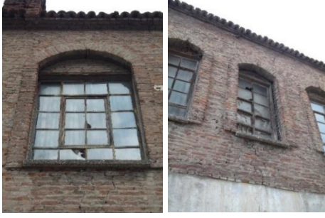
Resim 4.43. Geleneksel Egridir evlerinde kemerli pencere örnekleri
