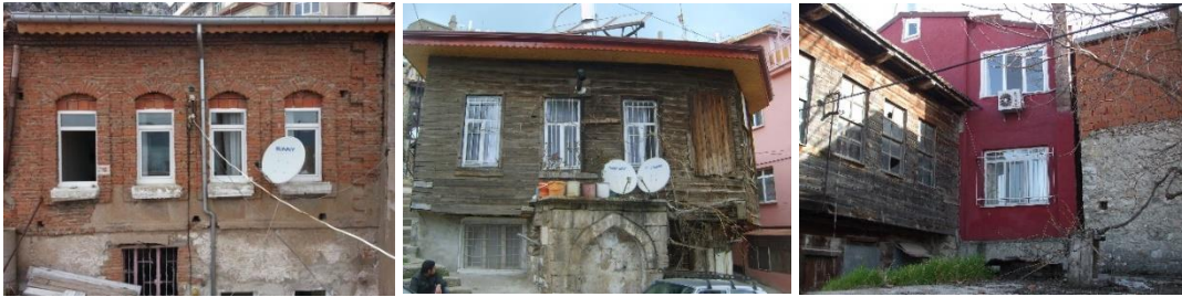
Resim 4.110. Yapıların cephelerinde yer alan çanak, klima vb. eklentiler
