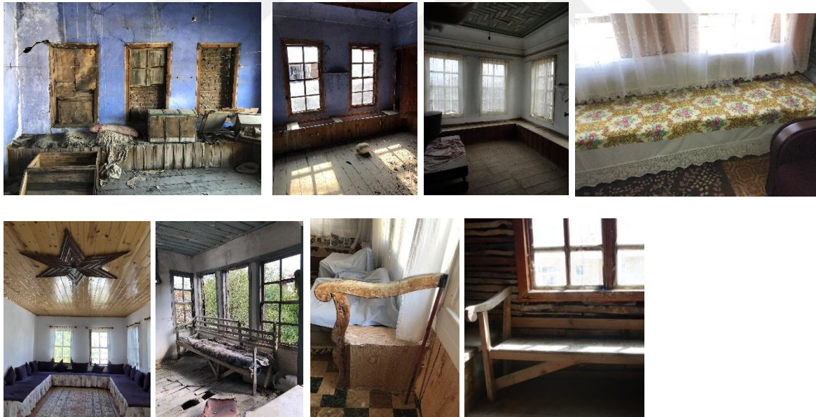
Resim 4.51. Geleneksel Eğirdir evlerinde seki ve sedir örnekleri
