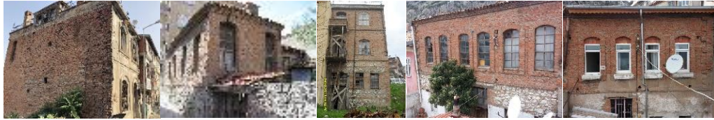
Resim 4.67. Geleneksel Eğirdir evlerinde alt katı taş, üst katı yığma tuğla yapı sistemi örnekleri
