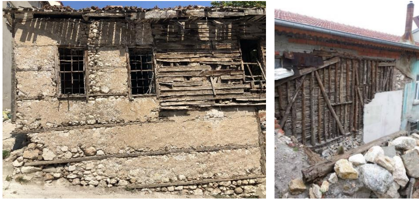
Resim 4.64. Geleneksel Eğirdir evlerinde taş ve ahşabın bir arada kullanımı
