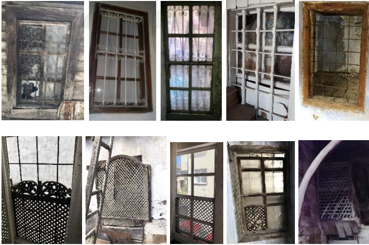
Resim 4.42. Geleneksel Eğirdir evlerinde demir parmaklık ve ahşap kafes örnekleri
