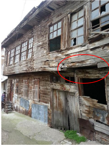
Resim 4.94. Tüm cephe boyunca devam eden çıkma üç mülkiyete ayrılan yapının orta kısmında öne doğru eğilerek aksından ayrılmıştır
