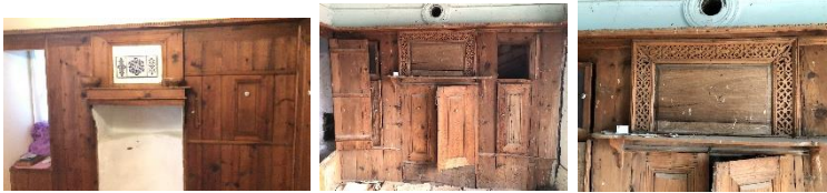
Resim 4.45. Geleneksel Egridir evlerinde düz ocak örnekleri
