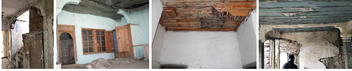
Resim 4.58. Geleneksel Eğirdir evlerindeki sofalarda görülen profilli kolon başlığı ve tavan kemerleri örnekleri
