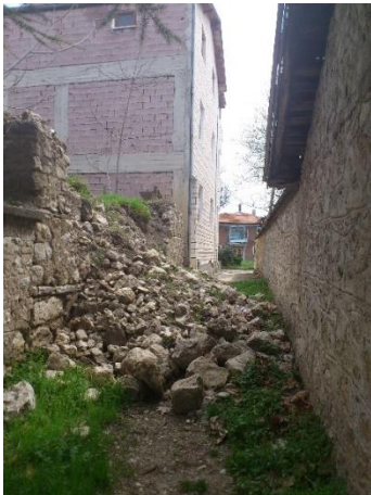
Resim 4.115. Harap yapının yıkılarak yola düşmesi
