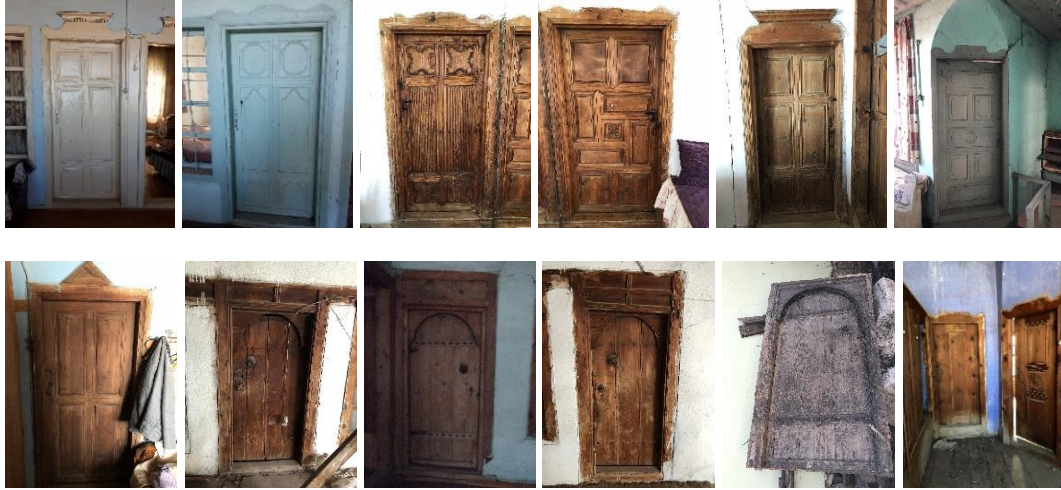
Resim 4.38. Geleneksel Eğirdir evlerinde profilli, üçgen, kemerli alınlıklı, tek kanatlı iç kapı örnekleri
