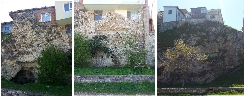
Resim 4.92. Kale Mahallesinde kale duvarlarına ve kayalara inşa edilen evler
