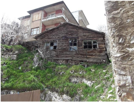
Resim 4.91. Zemin özelliklerinin kötü olması nedeniyle strüktürde eğilme örneği
