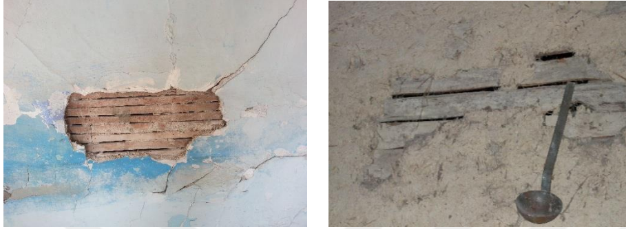
Resim 4.68. Geleneksel Eğirdir evleri bağdadi sıva örnekleri
