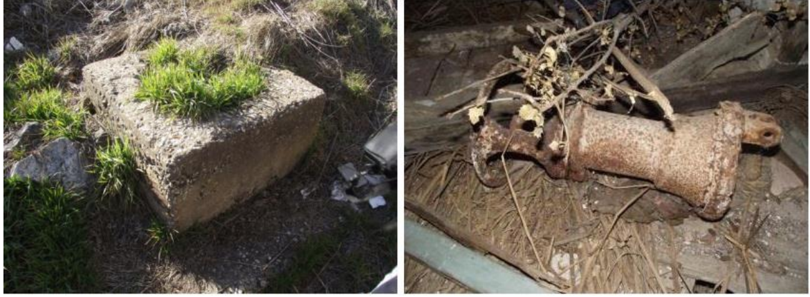
Resim 4.19. Yeşilada Hamamı su kuyusu ve pompası (Gökarslan, 2014)
