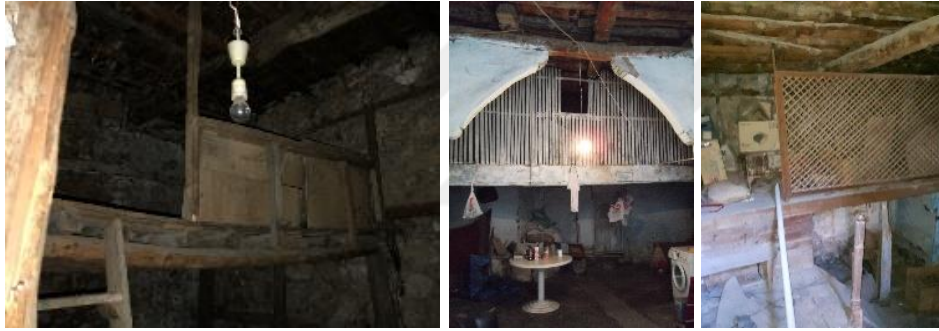
Resim 4.34. Geleneksel Eğirdir evlerinde çeşitli bölücü elemanlar ile ayrılan ara katlar
