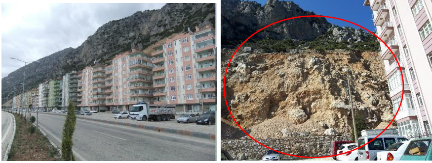
Resim 4.89. İmaret Mahallesi'nde yeni inşa edilen apartmanlar ve topoğrafyaya yapılan müdahaleler
