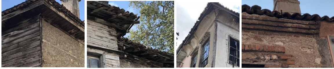
Resim 4.69. Altı kapalı, altı açık, profilli ve kirpi saçak tipleri
