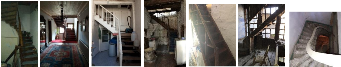
Resim 4.28. Geleneksel Ege evlerinde U, L, I, C formlu merdiven örnekleri
