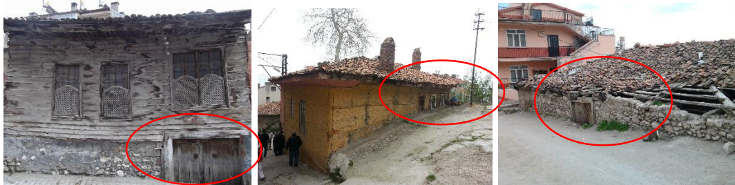
Resim 4.101. Zamanla yükselen yol kotları ile geleneksel yapılara girişlerin zorlaşması
