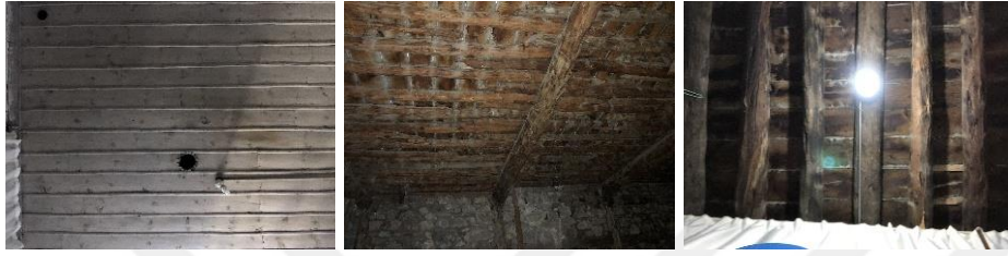
Resim 4.59. Geleneksel Eğirdir evlerinde düz tavan ve kirişlemeli tavan örnekleri
