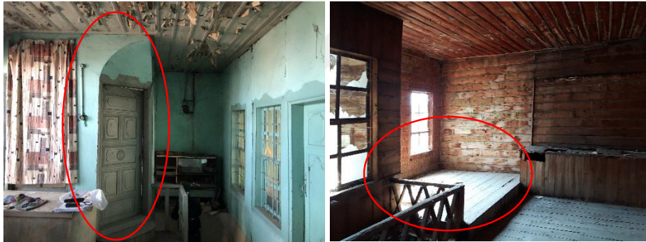
Resim 4.26. Sofadan birkaç basamak ile köşe pah yüzeyden geçilen oda girişi; Sofadaki kot ile yükseltile köşk kısmı
