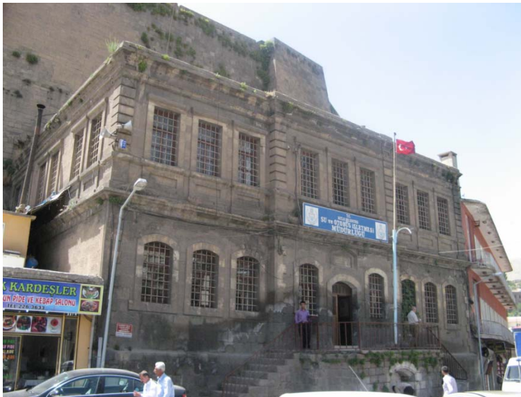
Resim 8.2. Eski Belediye binası
