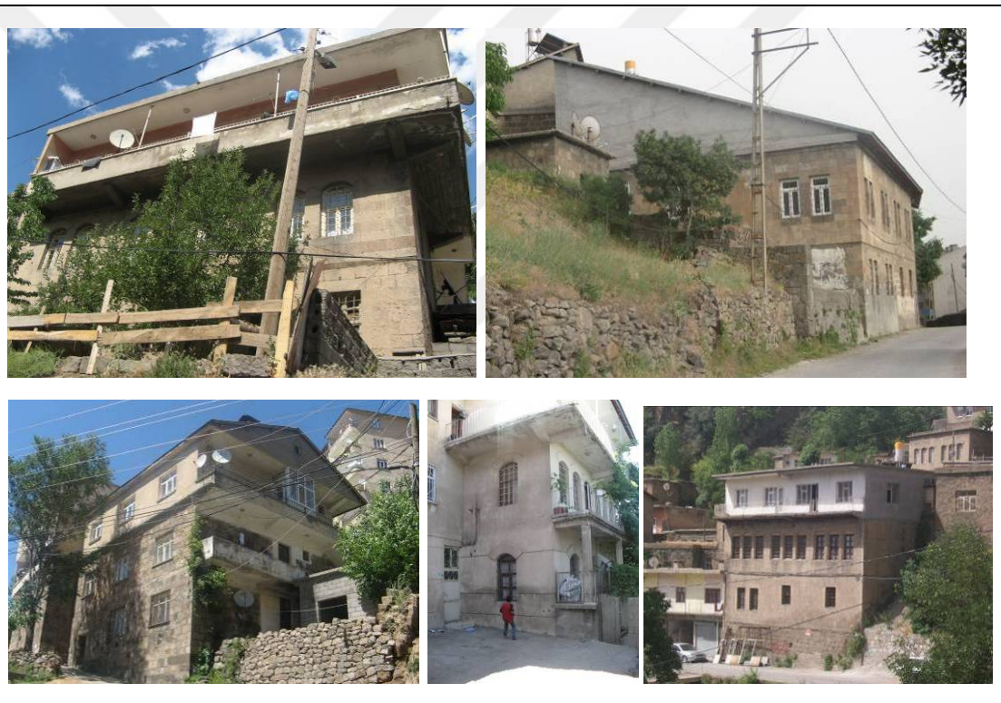
Resim 6.6. Betonarme kat ve çatı eklenmesi
