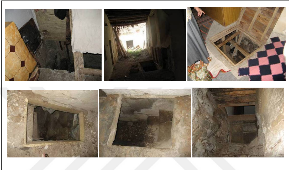
Resim 5.18.Alt kat bağlantı kapakları ve merdivenleri
