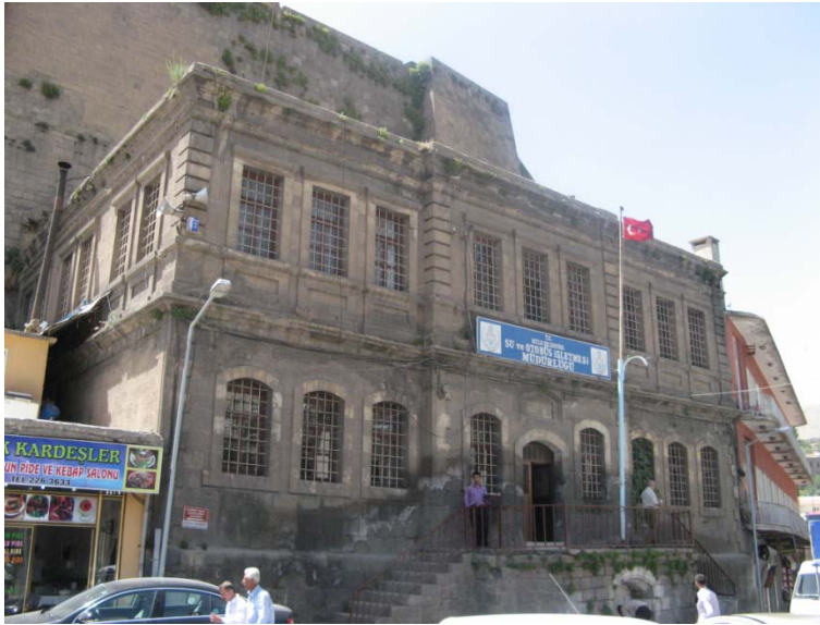
Resim 8.2. Eski Belediye binası
