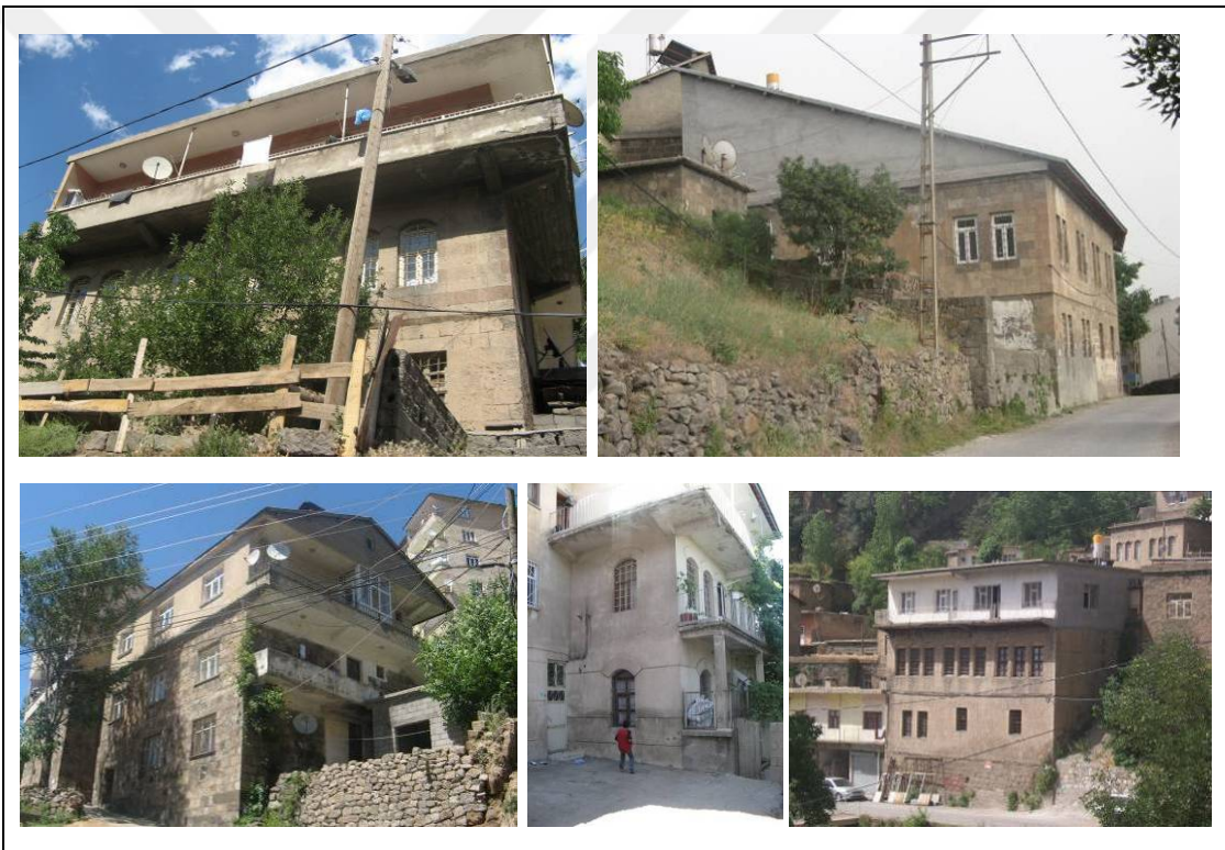
Resim 6.6. Betonarme kat ve çatı eklenmesi
