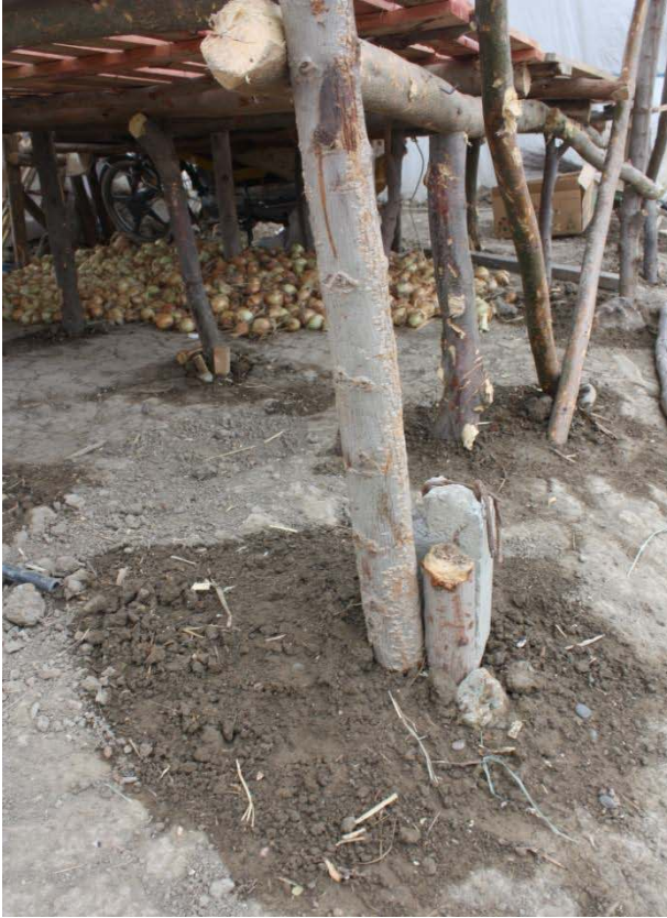
(Ek 3.4. – e): ıslak zemin çökme detayı
