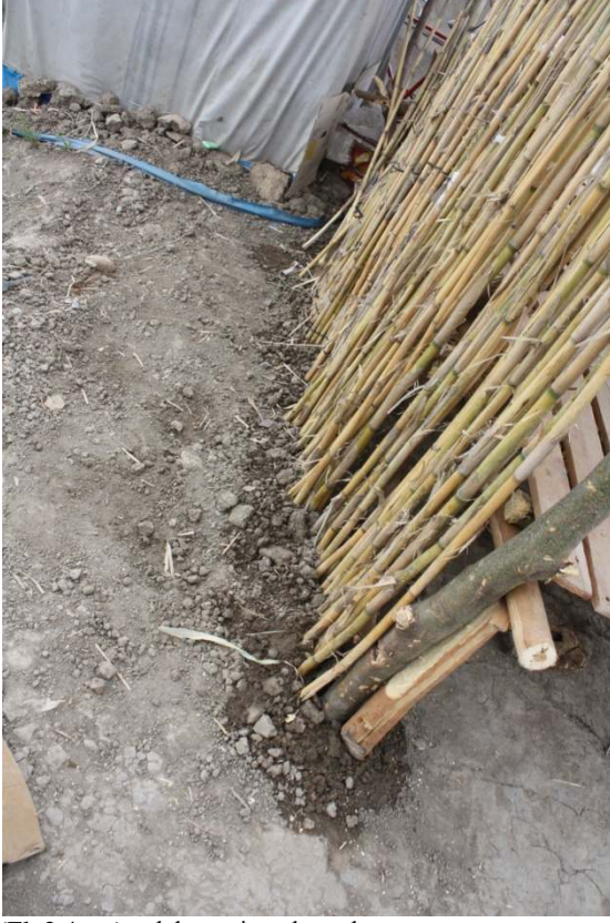
(Ek 3.4 – e): ıslak zemin çökme detayı
