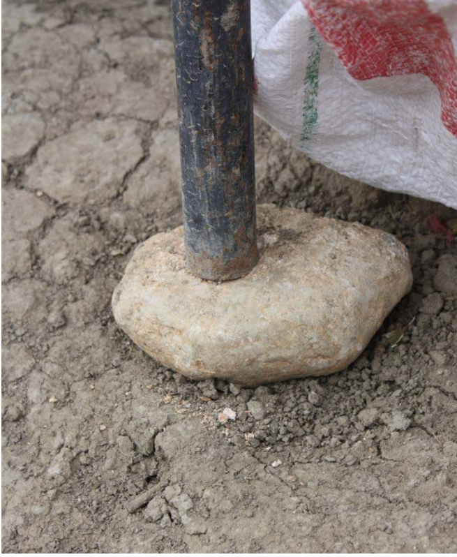
(Ek 3.4 – d): zemin detayı – taşla yükseltme
