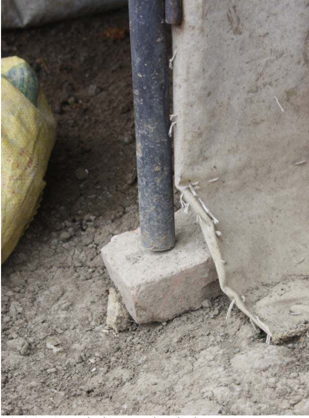
(Ek 3.4 – d): zemin detayı - taşla yükseltme
