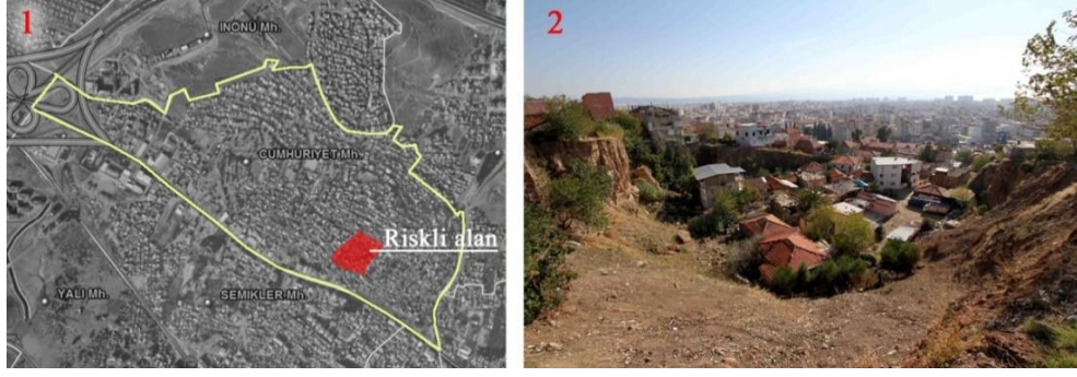
Şekil 4.36 Cumhuriyet Mahallesi sınırları içerisinde yer alan riskli alan, (Sınırlar İzmir üç boyutlu kent rehberi üzerine işlenmiştir.) 2) Heyelan bölgesi olan riskli alandan görünüm (Karşıyaka Belediyesi, b.t.)
