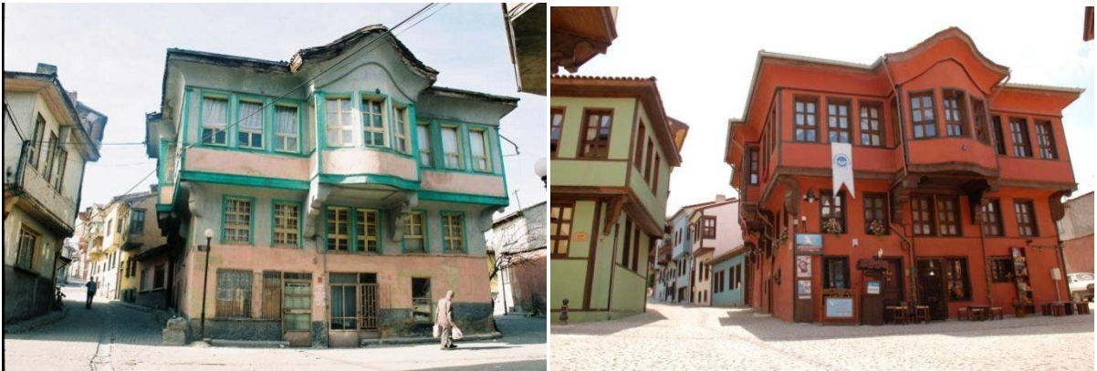
Foto 3.4. Iřıklar Sokak, Saėlıklařtırma ncesi ve Sonrası Durumu
