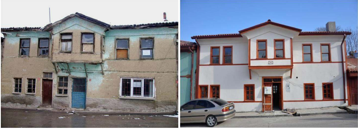
Foto 3.8. Malhatun Sokak, Saęlıklaştırma Öncesi ve Sonrası Durumu
