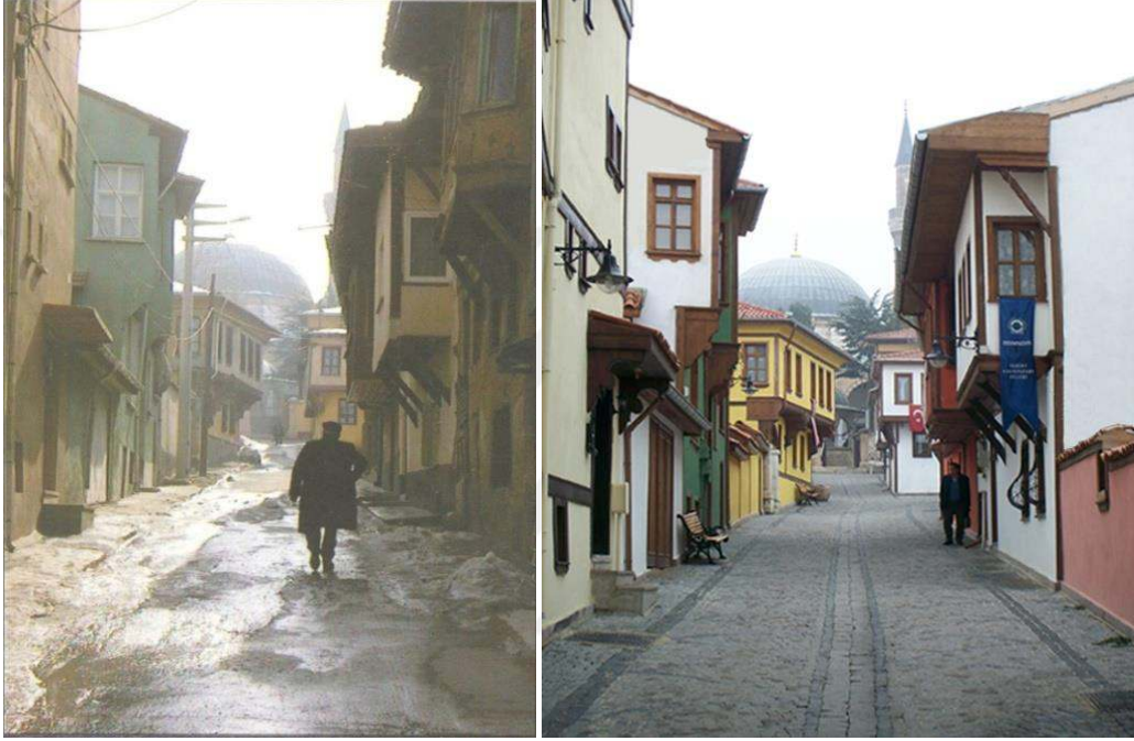
Foto 3.3. Kurşunlu Cami Sokak, Saėlıklařtırma ncesi ve Sonrası Durumu
