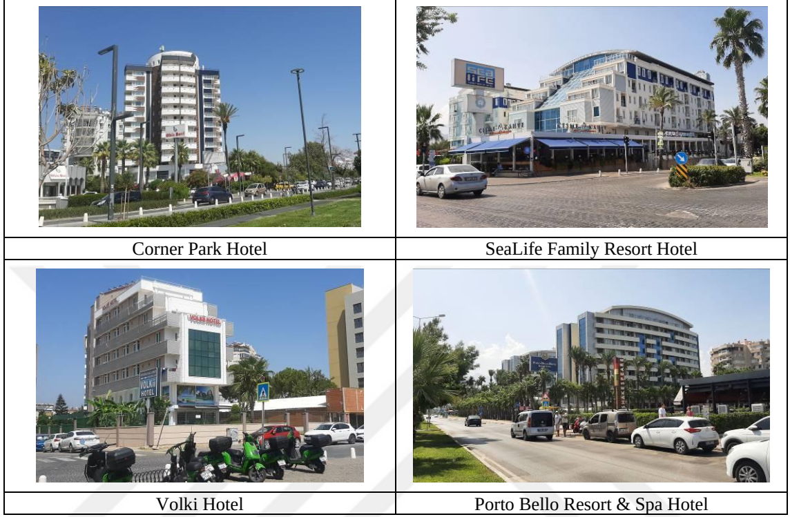
Şekil 5.16. Kıyı üzerinde bulundukları konum nedeniyle nirengi noktası olma özelliği gösteren otel yapıları (Çevrimli arşivi)
