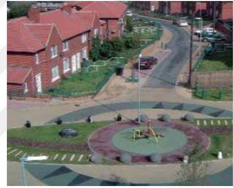
Görsel 3.28 Görsel Moorside, Dewsbury şehri, Home Zone uygulanan bir sokak (Kaynak: NACTO, 2005)
