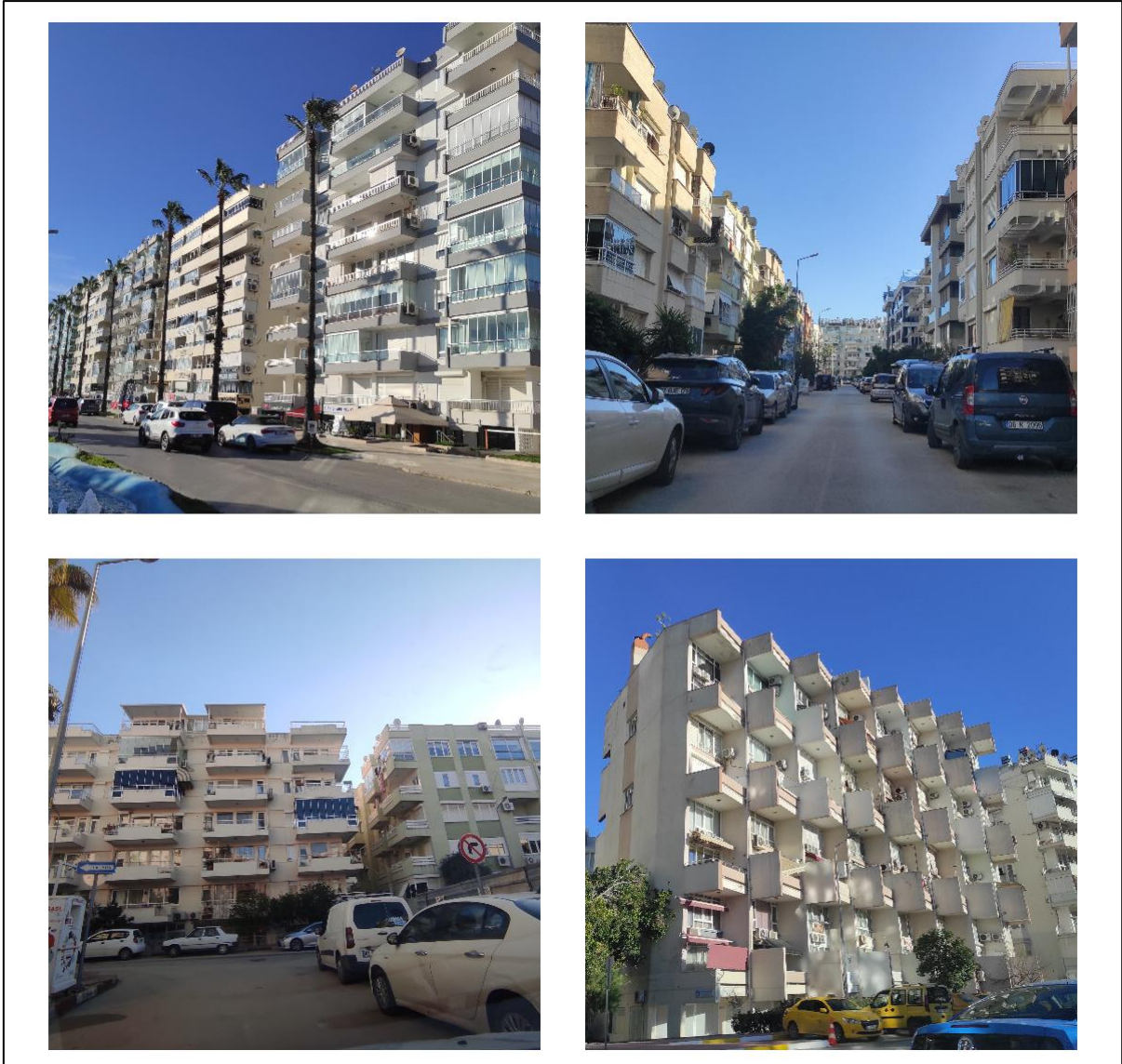
Fotoğraf 4.8 Bahçelievler Mahallesi (16.01.2025)
