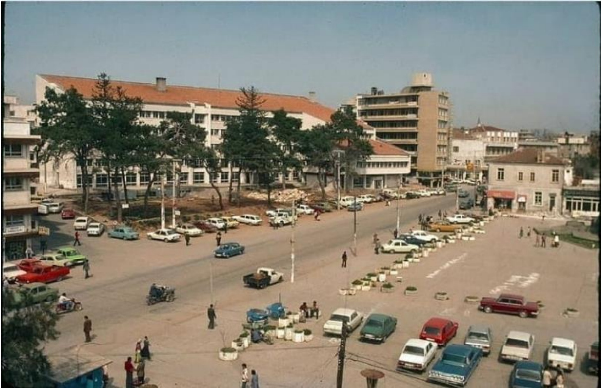
Fotoğraf 5.2 Antalya Kenti Yıkılan Betonarme Hükümet Konağı (Bektaş, 2024)
