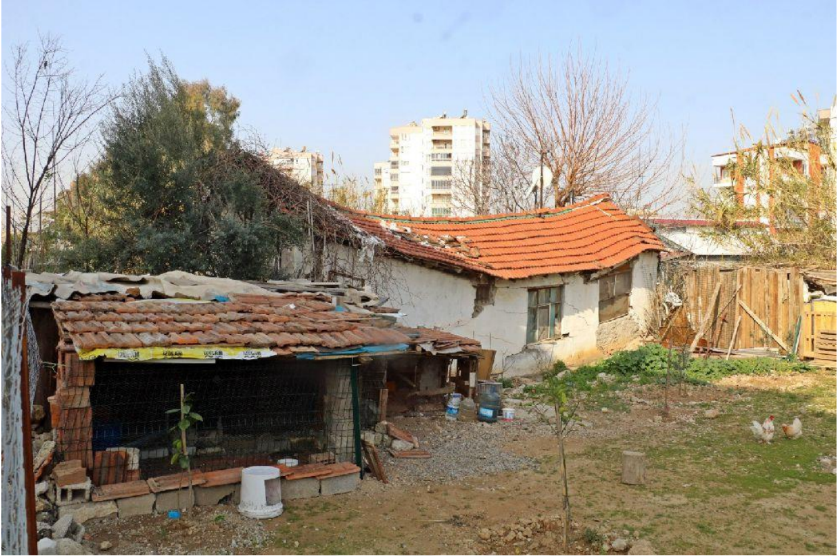
Fotoğraf 1.6 Eğilme Gösteren Müstakil Konutlar (DHA, 2020)
