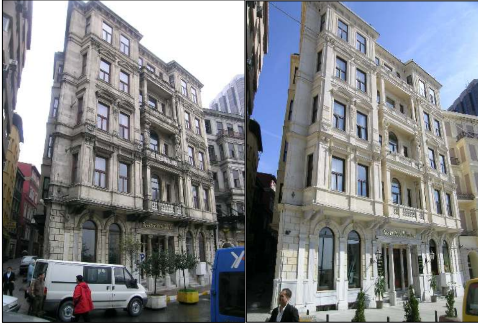
Resim 4.7. Güzel Beyoğlu projesi kapsamında yapılan restorasyon çalışması [Sarıcı, 2008]
