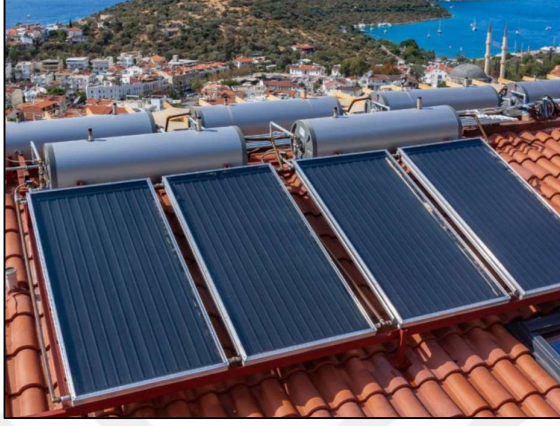
Şekil 4.17. Güneş enerjili su ısıtma ünitelerinin evlerin çatılarında görülmesi
