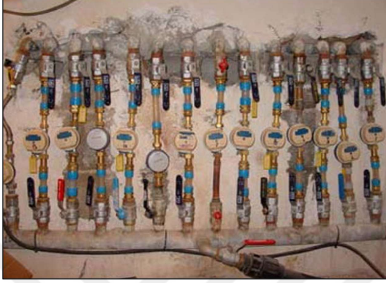
Şekil 2.9. Bazı incelenen tek jetli sayaçların yetersiz montaj pozisyonu (Palau vd. 2018)
