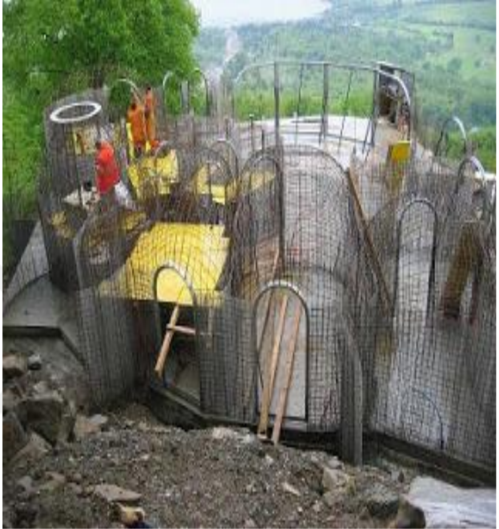
Şekil 97: Yeryüzü Evlerinin Metal Konstrüksiyonu
