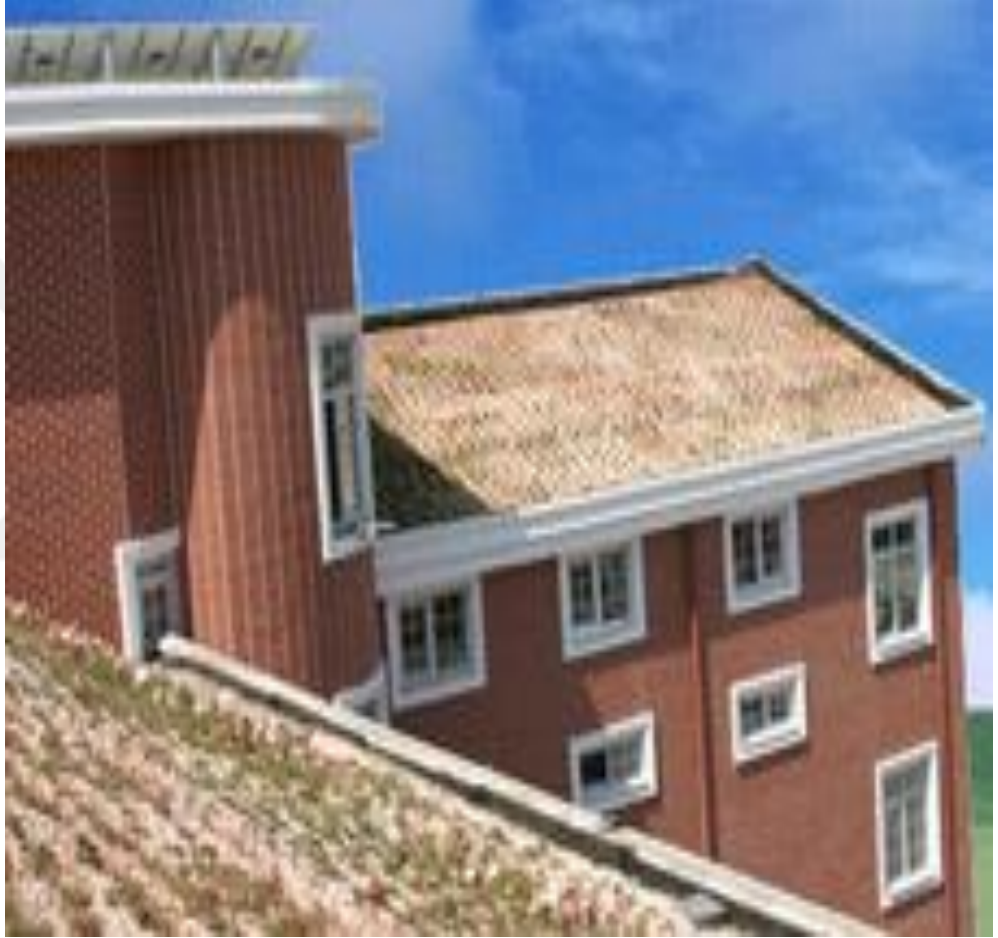
Şekil 220: H. Avni İncekara Fen Lisesi Yurt Binası
