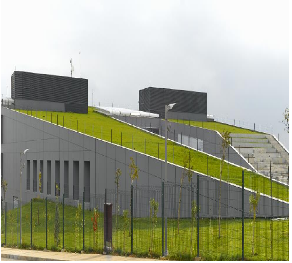
Şekil 200: Turkcell AR-GE Binası Genel Görünüş
