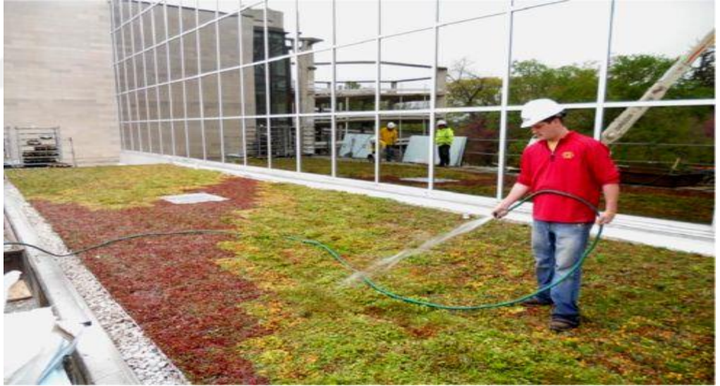
Şekil 56: Yeşil Çatı Periyodik Bakım
