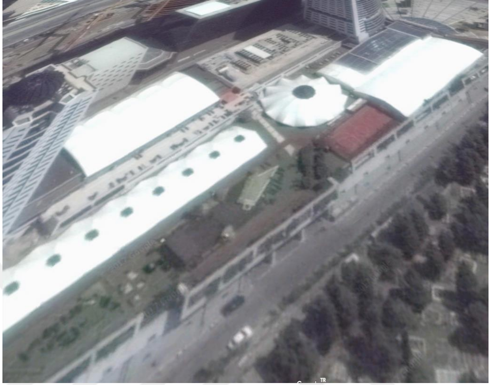
Şekil 221: Metrocity Yeşil Çatısının Uydudan Görüntüsü
