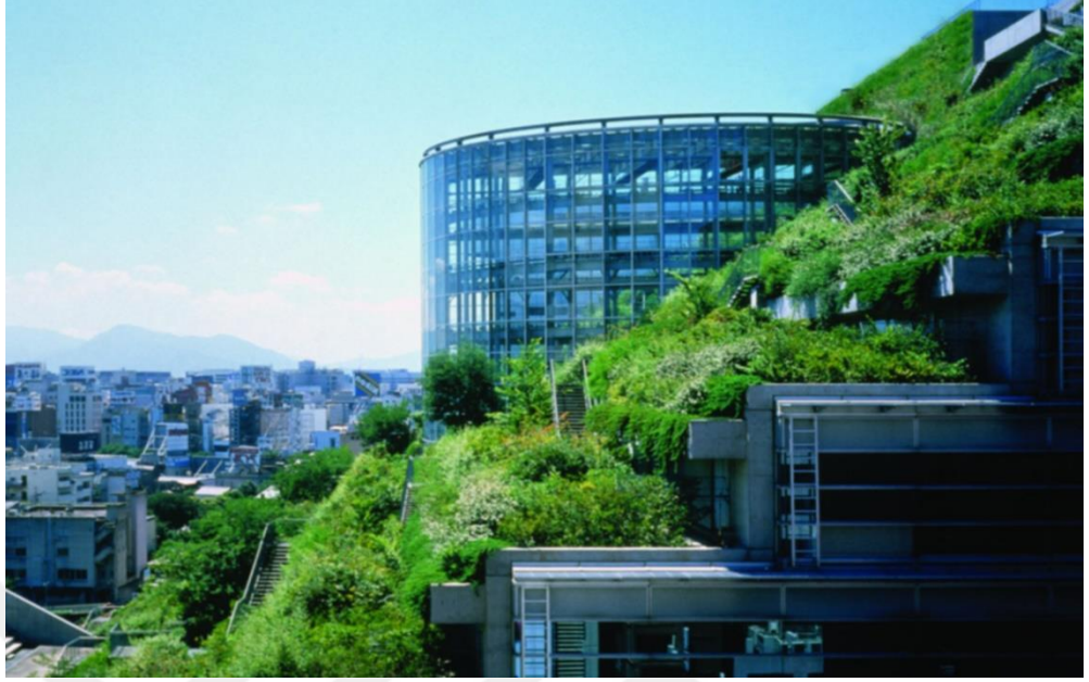
Şekil 114: Acros Binası Gözlem Güvertesi
