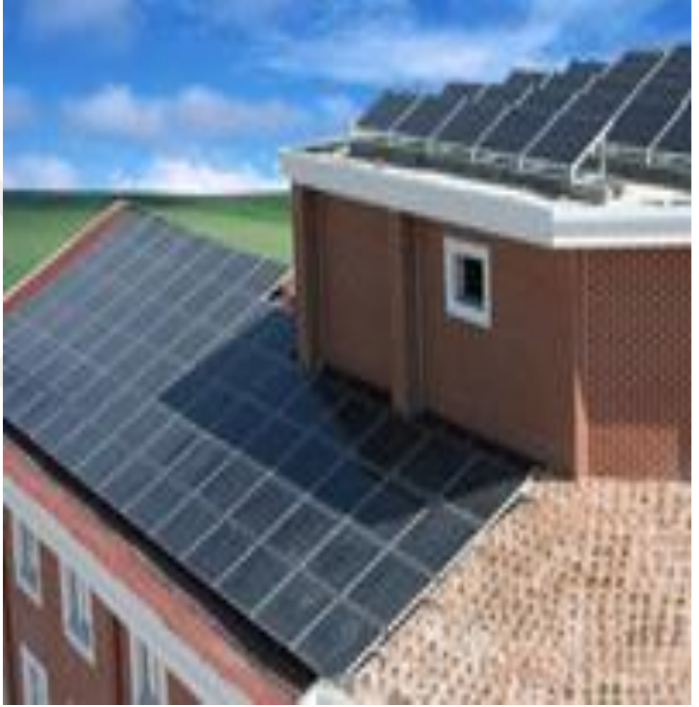
Şekil 219: H. Avni İncekara Fen Lisesi Yurt Binası
