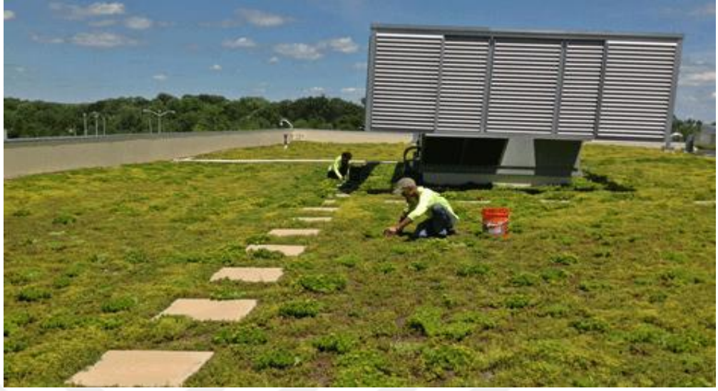
Şekil 55: Yeşil Çatı Bakımı
