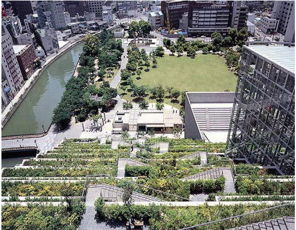
Şekil 108: Acros Binası, Japonya
