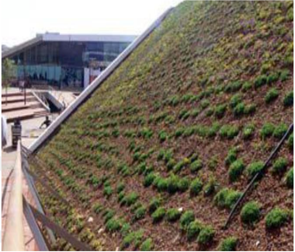
Şekil 196: Aşırı Eğimli Yeşil Çatıdan Bir Görünüş
