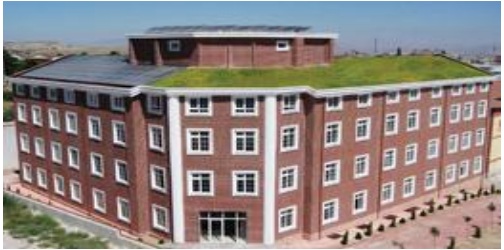
Şekil 218: H.Avni İncekara Fen Lisesi Yurt Binası
