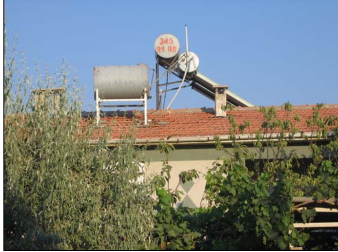
Şekil 6.9 Evka-1 yerleşiminde güneş enerjisi kullanımı.
