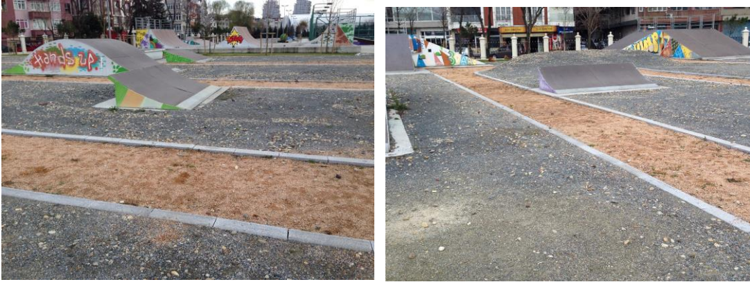
Şekil 4.96 : Yüzey boyama ve graffiti çalışmaları.
